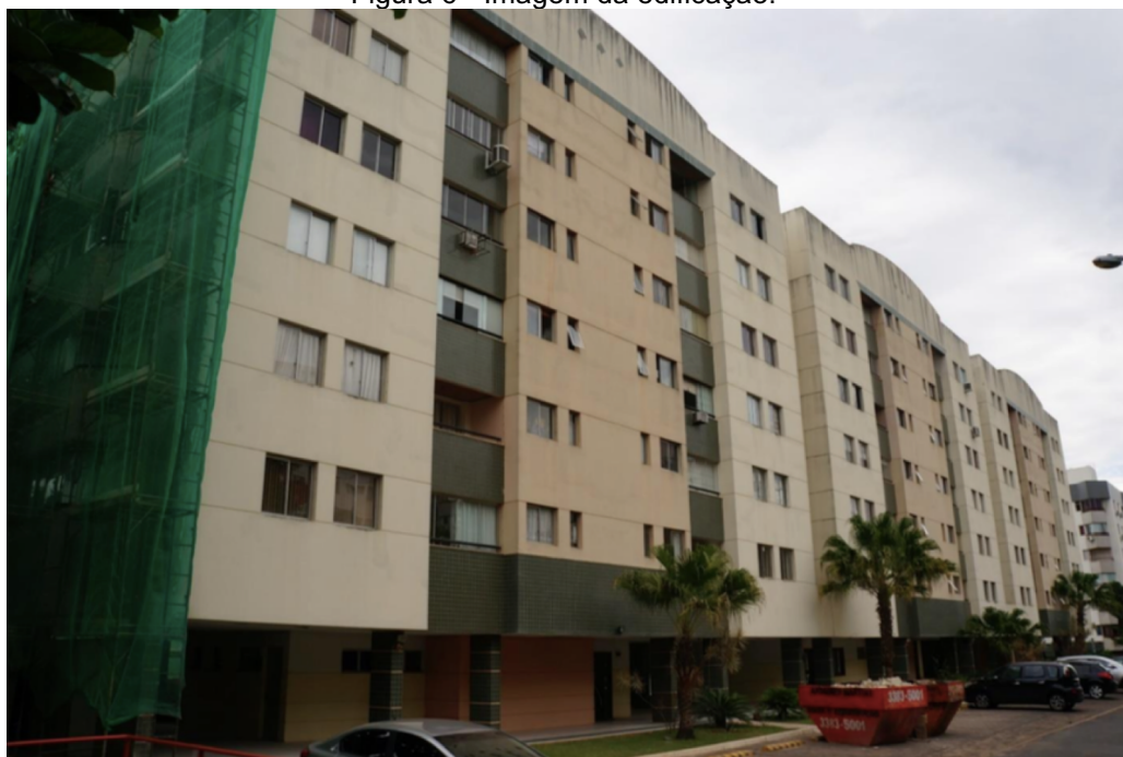
Figura 6 - Imagem da edificação.
