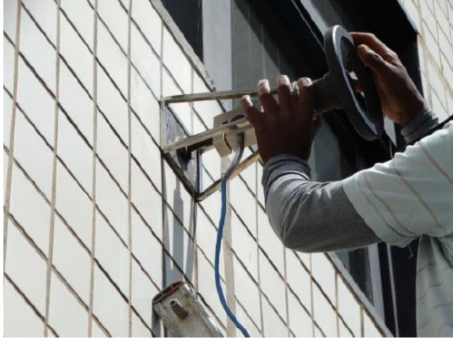
Figura 12 - Acoplagem do equipamento.
