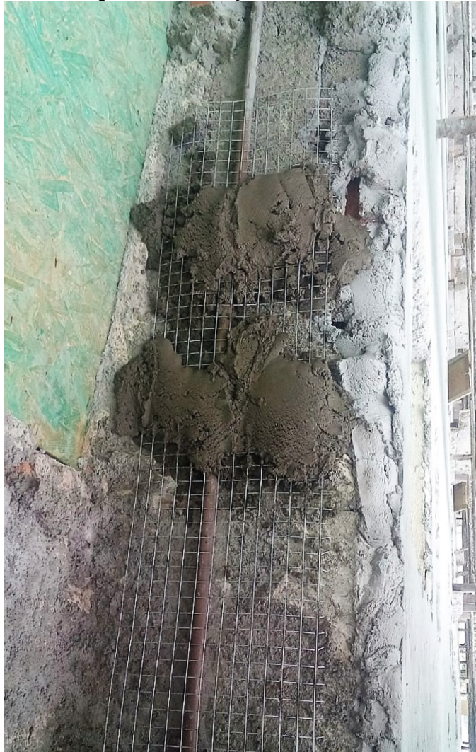
Figura 15 - Instalação da tela metálica.
