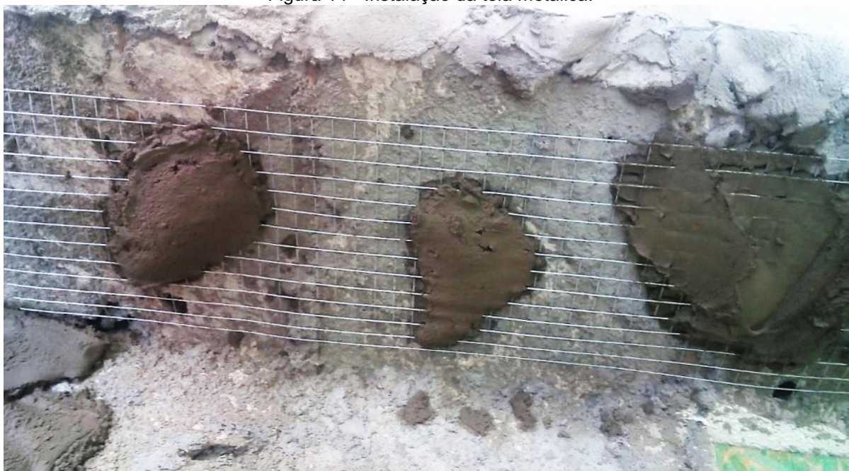
Figura 14 - Instalação da tela metálica.
