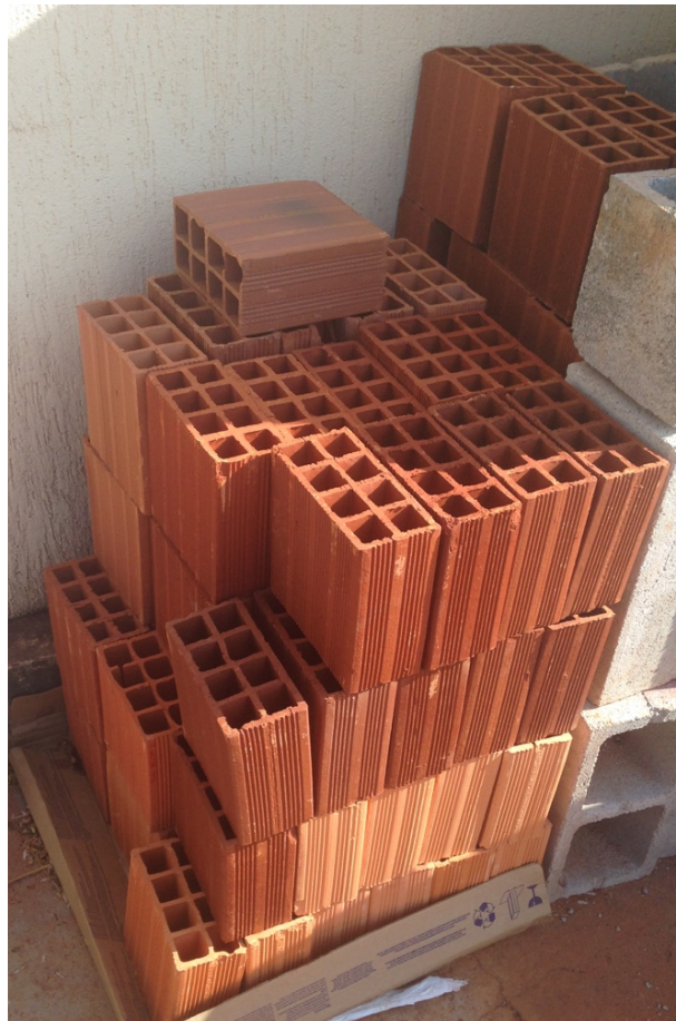
Figura 16: Armazenamento dos blocos.
