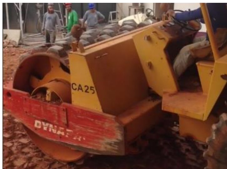
Figura 11- Rolo compactador Pé de Carneiro
