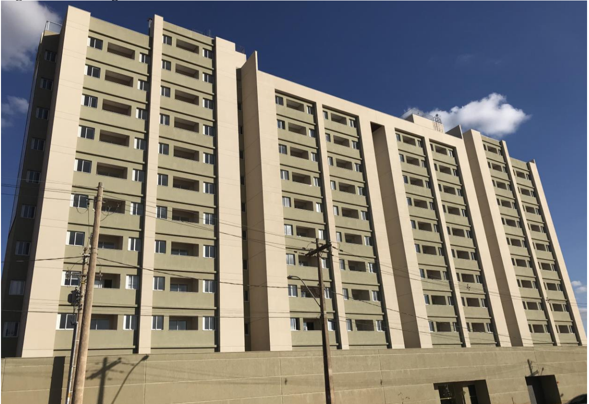
Figura 39 – Fotografia do edifício.
