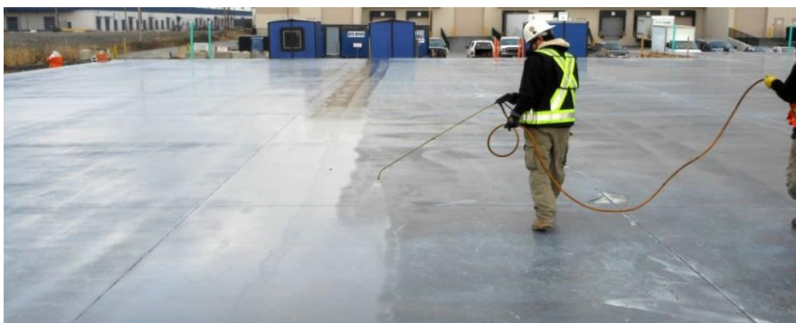
Figura 15 – Cura de um concreto
