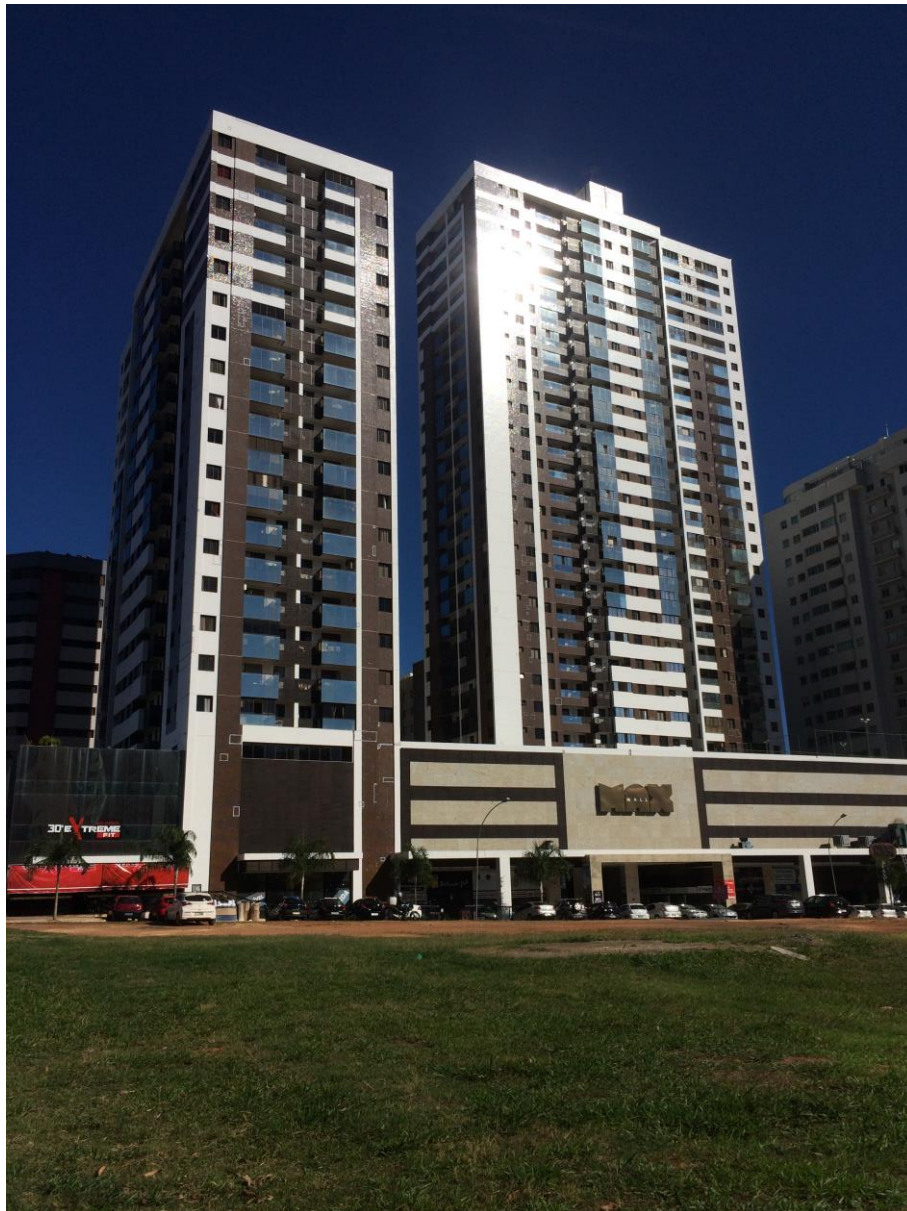
Figura 5 - Vista das Torres do Empreendimento Residencial / Comercial (Autor, 2017.)
