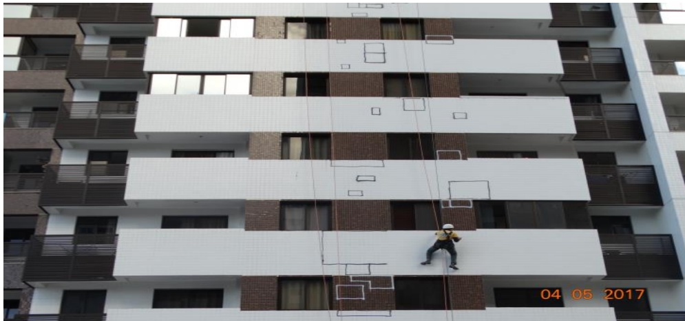
Figura 9 - Funcionários realizando ensaio de percussão na fachada, transporte vertical a rapel.
