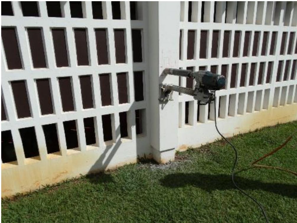
Figura 28 – Realização de extração de testemunho do pilar da edificação principal antiga.
