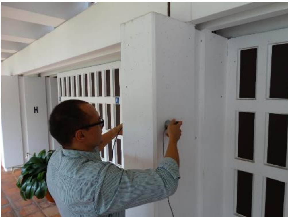
Figura 26 – Realização de ensaio de ultrassonografia em Pilar de Concreto Armado.
