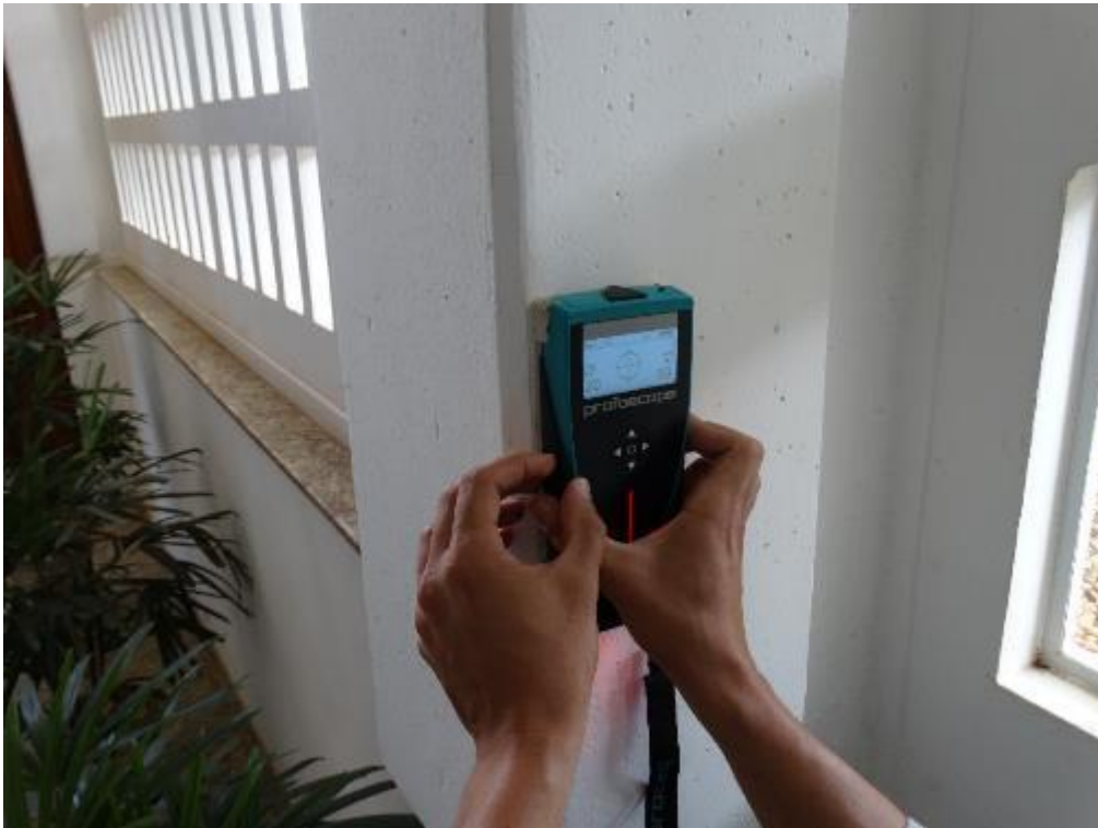
Figura 19 – Realização de ensaio de pacometria em pilar de concreto.
