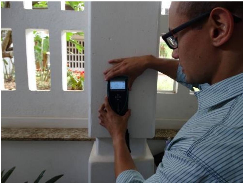
Figura 20 – Realização de ensaio de pacometria em pilar de concreto.
