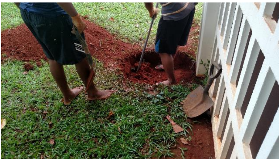
Figura 41 – Início da escavação.
