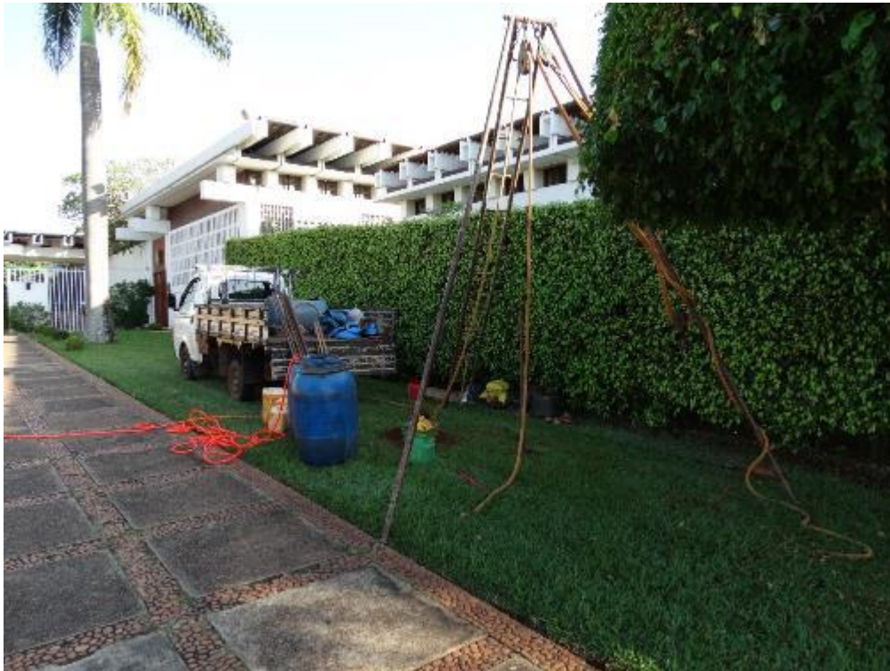
Figura 39 – Sondagem sendo realizada.
