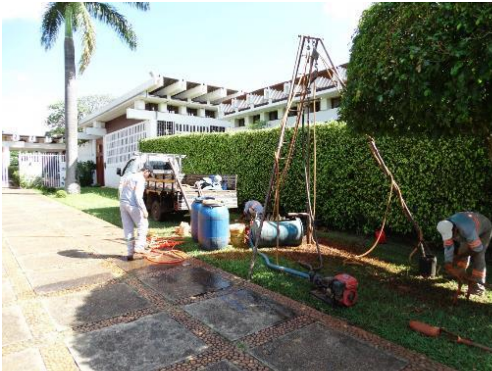
Figura 40 – Sondagem sendo realizada.
