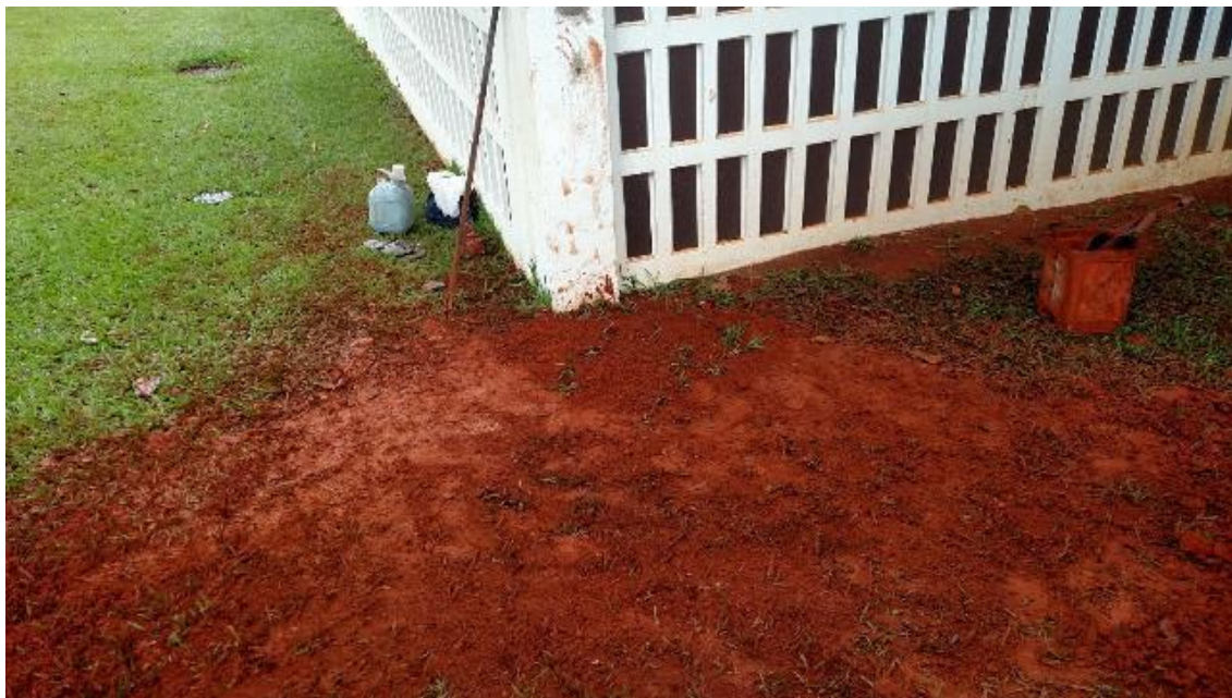
Figura 44 – Poço de inspeção fechado após escavação.
