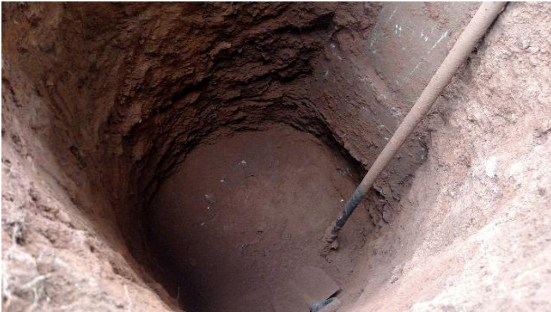
Figura 42 – Bloco de coroamento encontrado a 90 cm do nível do terreno.
