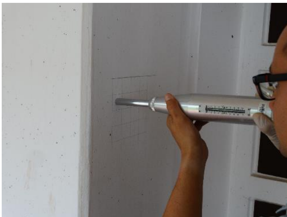
Figura 24 – Realização de ensaio de esclerometria em Pilar de Concreto Armado.
