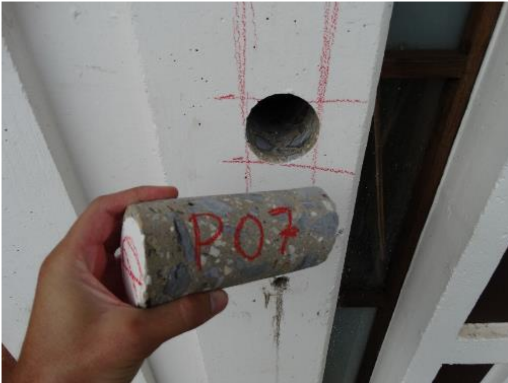
Figura 30 – Realização de extração de testemunho do pilar P07.
