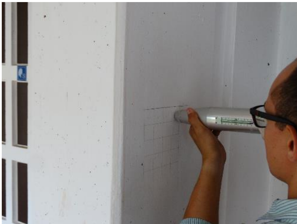
Figura 25 – Realização de ensaio de esclerometria em Pilar de Concreto Armado.
