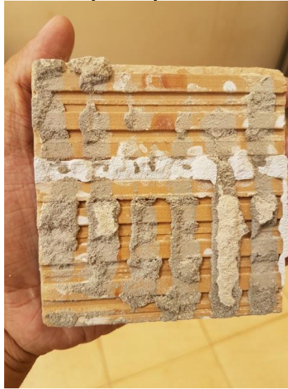
Figura 16 – Ruptura do corpo-de-prova do revestimento cerâmico
