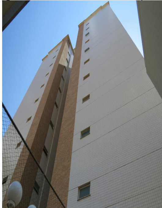
Figura 6 – Fachada lateral direita (Leste)
