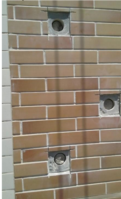
Figura 28 – Ensaio de determinação de resistência de aderência a tração no revestimento cerâmico tipo Gail e revestimento argamassado
