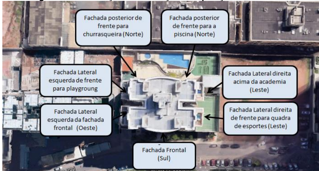
Figura 7 – Localização da edificação e disposição das fachadas
