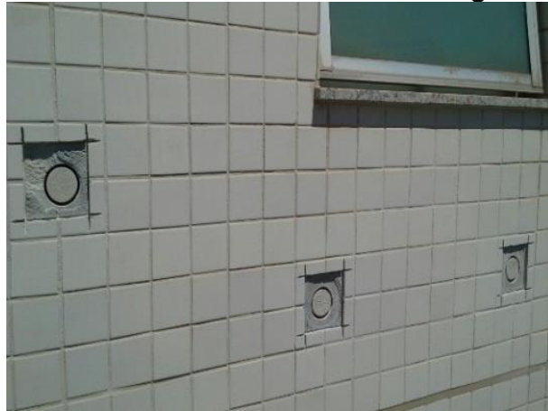
Figura 27 – Ensaio de determinação de resistência de aderência a tração no revestimento cerâmico branco e revestimento argamassado
