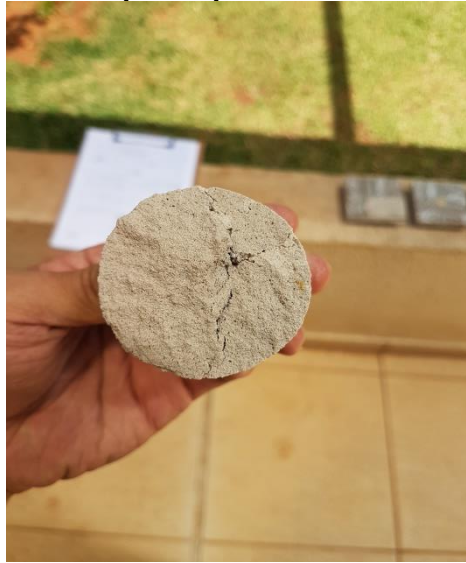
Figura 20 - Ruptura do corpo-de-prova do revestimento argamassado
