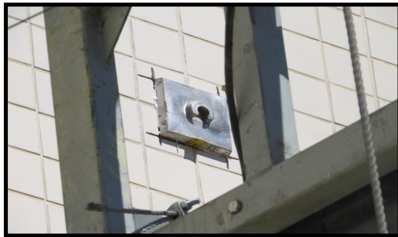
Figura 14 – Colagem das partilhas metálicas
