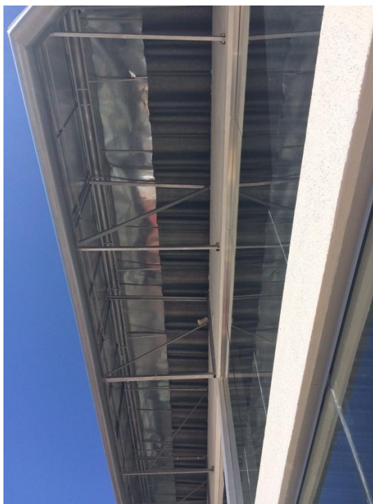
Figura 13 - Manutenção corretiva realizada para o problema "E"
