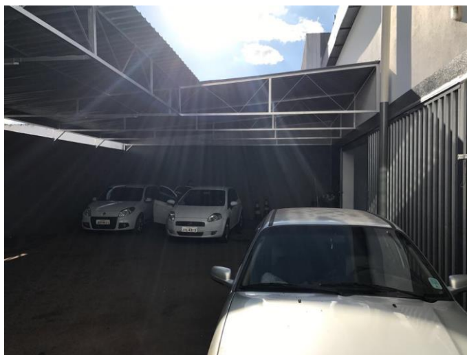
Figura 7 - Manutenção corretiva realizada para o problema "B"
