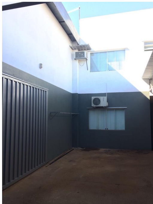
Figura 19 - Manutenção corretiva realizada para o problema "H"
