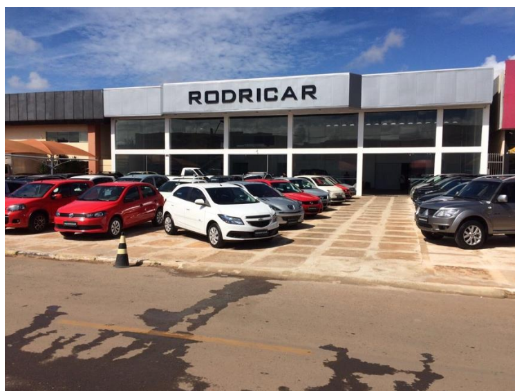
Figura 2 - Vista frontal da edificação
