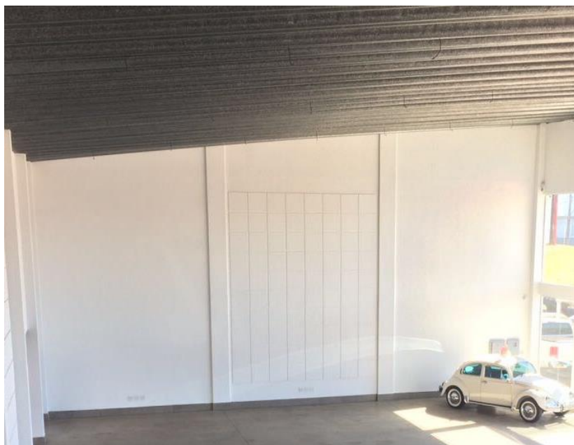
Figura 21 - Manutenção corretiva realizada para o problema "I"
