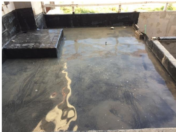
Figura 16: Teste de estanqueidade na área nº 2
