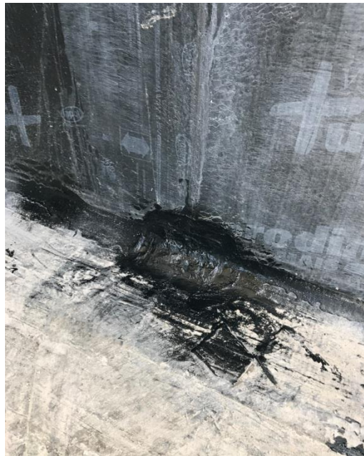
Figura 42: Reparo realizado em ponto de acusação de infiltração
