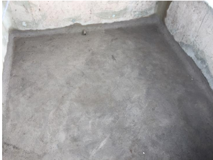
Figura 5: Regularização do piso
