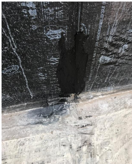
Figura 43: Reparo realizado em ponto de acusação de infiltração
