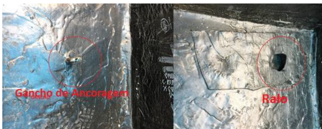
Figura 10: Visão dos ganchos de ancoragem, ralos e passagens de tubulação no piso da laje.
