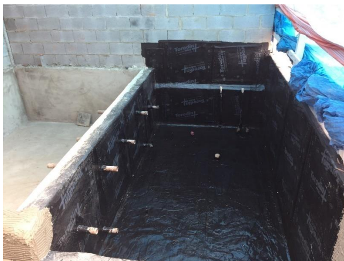
Figura 8: Impermeabilização da casa de máquina da piscina.
