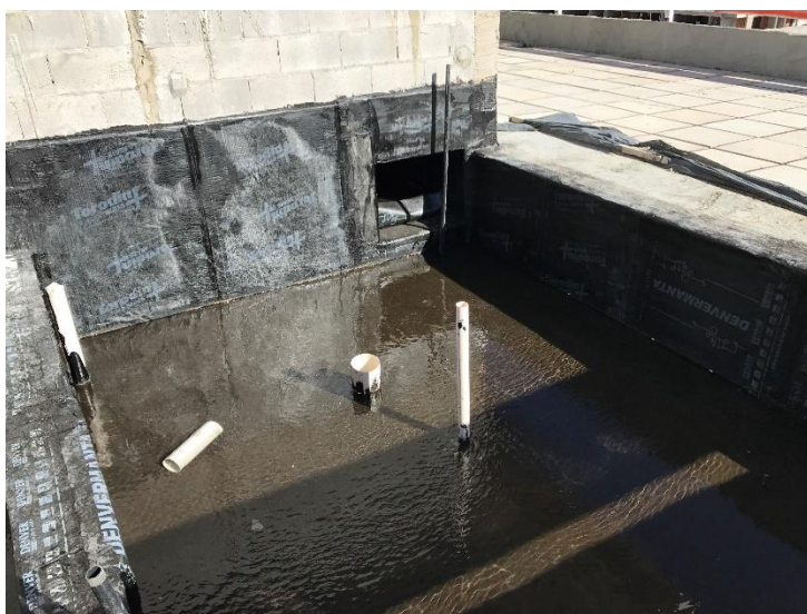
Figura 33: Realizando o teste de estanqueidade
