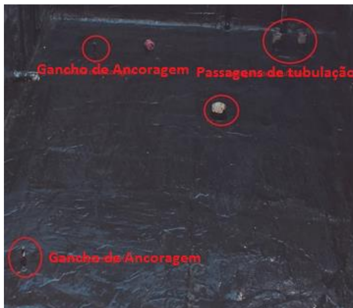
Figura 9: Visão dos ganchos de ancoragem, ralos e passagens de tubulação no piso da laje.
