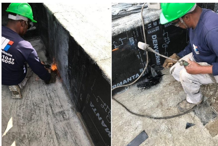
Figura 44: Reparo realizado em ponto de acusação de infiltração
