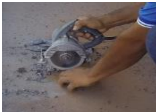
Figura 14 - Retirada das camadas granulares em contato com o revestimento.
