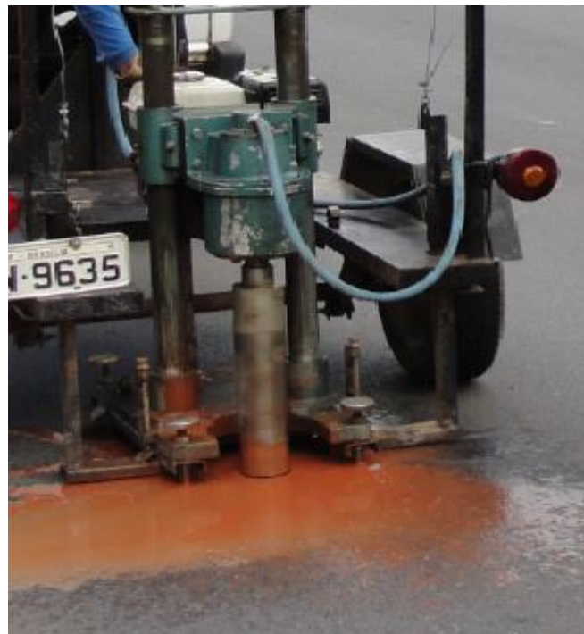
Figura 10 - Extração de corpos de provas asfálticos.
