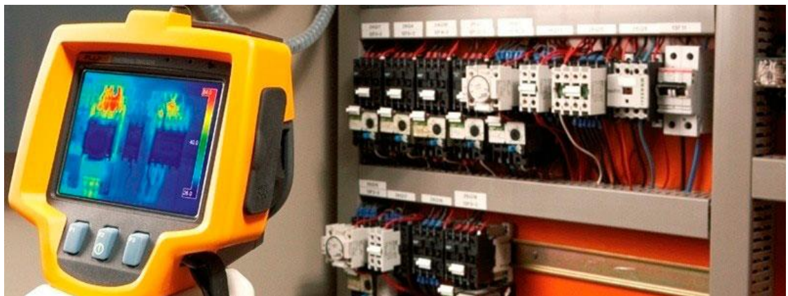
Figura 4 - Ensaio termográfico de quadros elétricos
