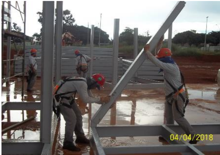
Fotografia 34 - MONTAGEM DE UM MÓDULO
