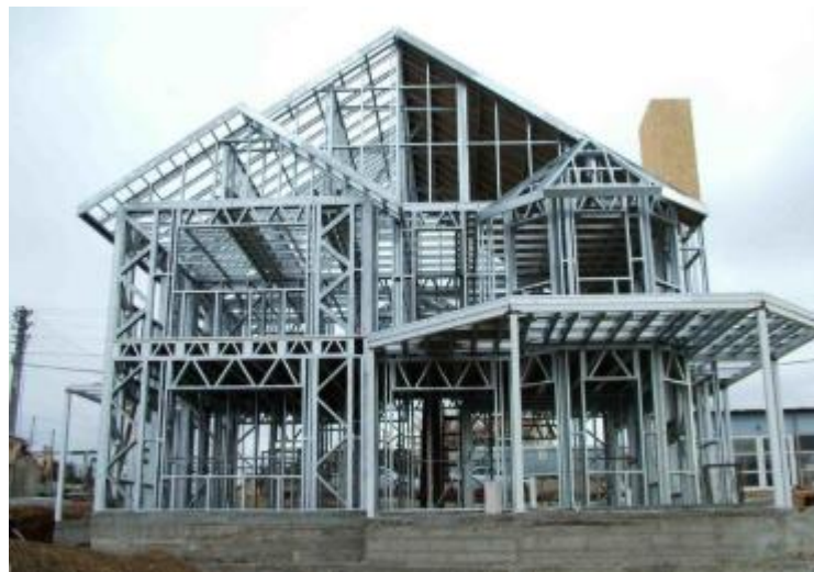
Fotografia 9 - CASA EXECUTADA EM STEEL FRAME
