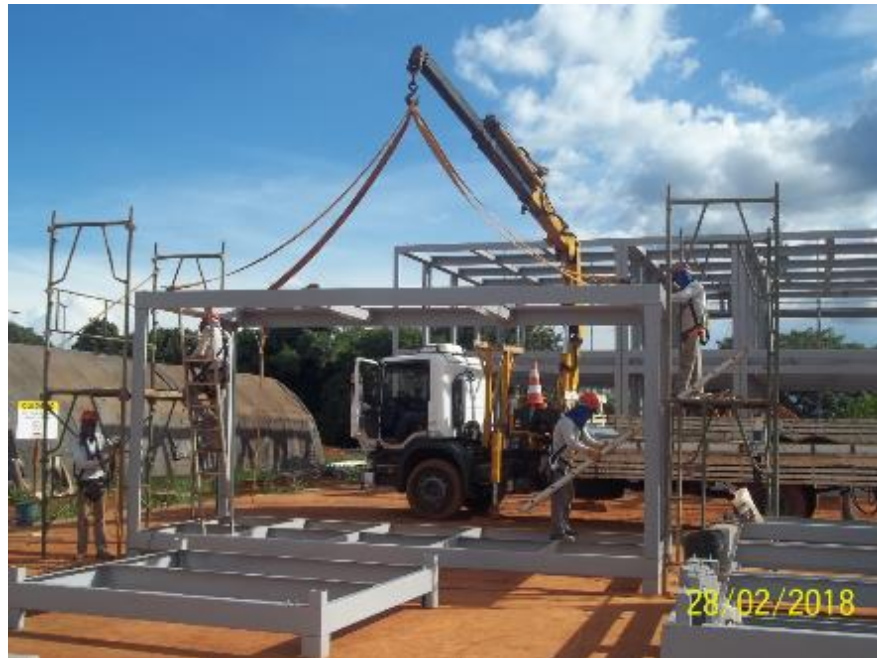
Fotografia 35 - MÓDULO MONTADO E SENDO POSICIONADO
