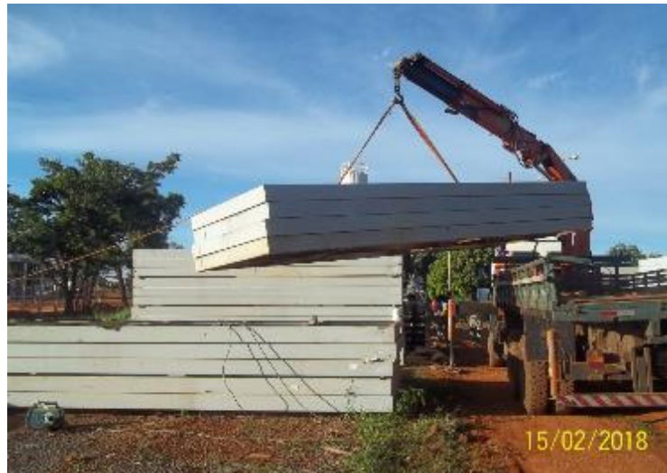
Fotografia 16 - CAMINHÃO MUNK CARREGANDO ESTRUTURAS
