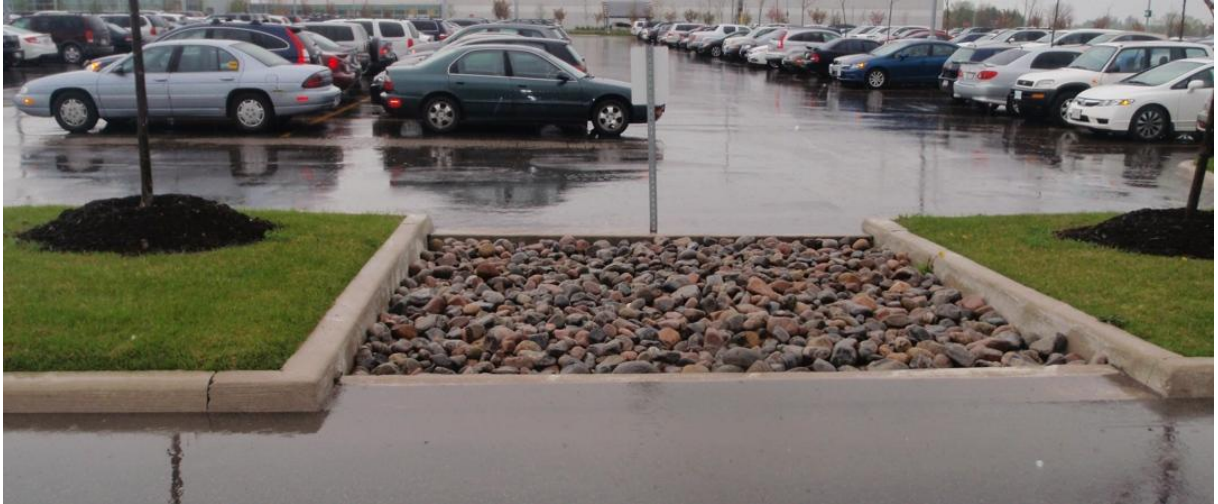
Figura 13 - Trincheira de infiltração de um estacionamento público em Toronto, Canadá
