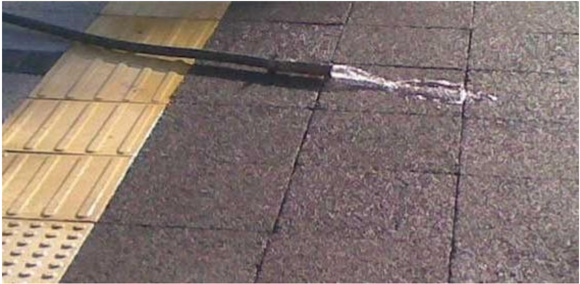
Figura 9 - Pavimento permeável possibilitando infiltração da água
