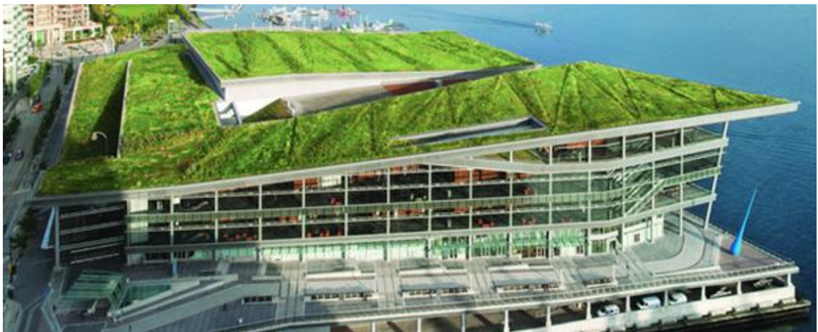
Figura 10 - Telhado verde na cobertura do Centro de Convenções de Vancouver, Canadá
