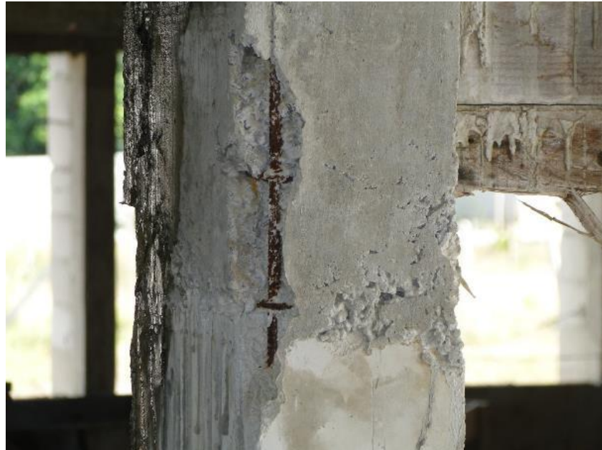
Figura 9 - Pilar sem revestimento em São Mateus
