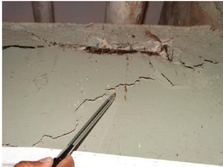
Figura 5 - Trinca por expansão da barra de aço – Laudo da 116 norte
