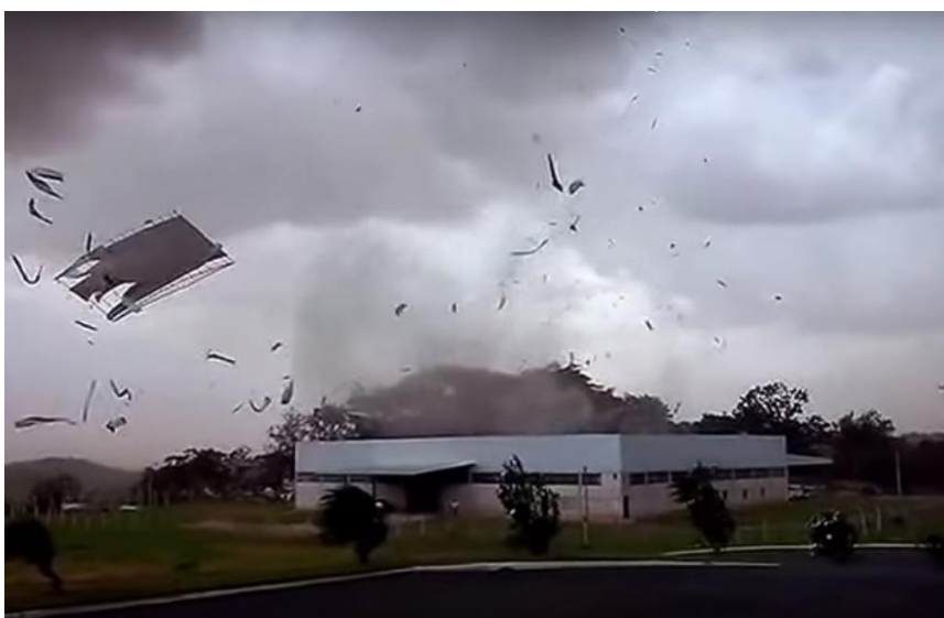
Figura 2 – Efeito do vendaval que desabou paredes e destelhou um galpão de uma lavanderia no noroeste do Paraná, em janeiro de 2015.
