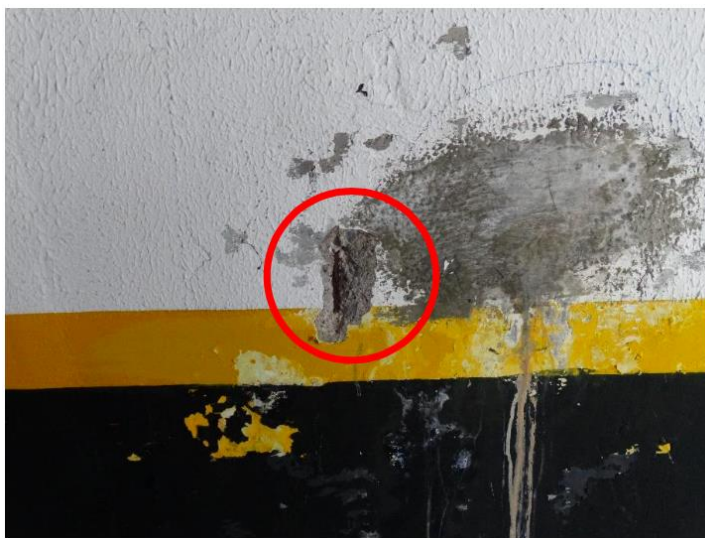
Figura 23 - Armadura amostra da cortina de contenção
