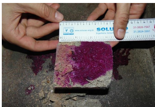
Figura 25 – Ilustração do ensaio de avaliação de frente de carbonatação por meio da aplicação da fenolftaleína
