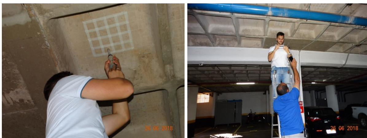
Figura 54 – Realização do ensaio 5 de esclerometria na laje nervurada acima da vaga 1005 (identificação do condomínio)
