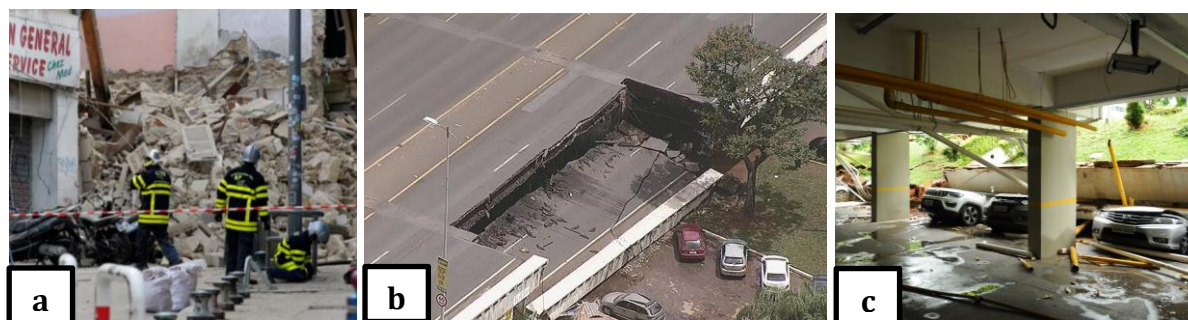
Figura 16 – Desabamentos na construção civil por falta de inspeção técnica e devida manutenção
