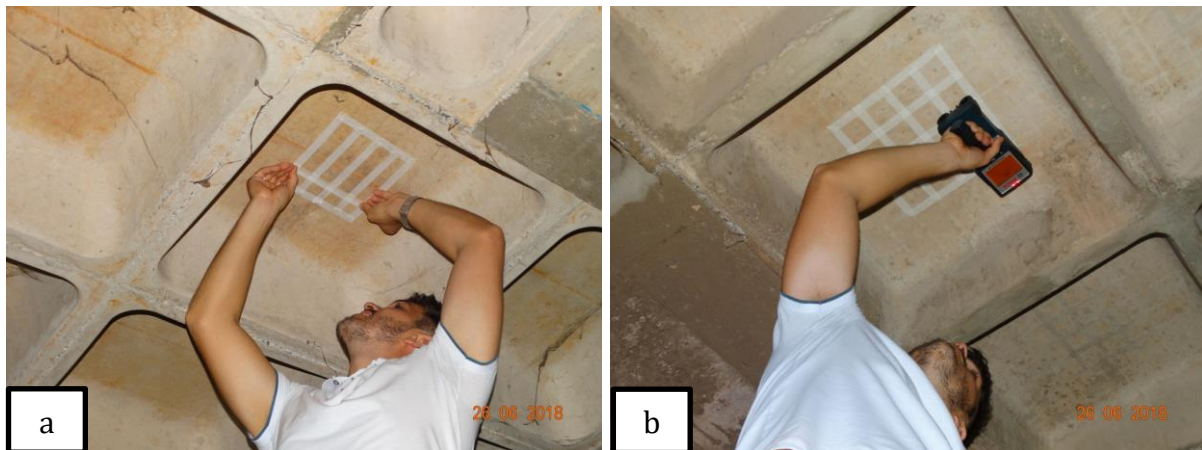
Figura 49 – Elaboração da malha in locu. a) Utilização de fita adesiva na cor branca. b) Utilização do pacômetro para mapeamento das barras de aço
