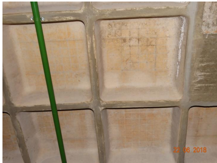
Figura 47 – Visualização nítida das exatas posições das barras de aço na laje nervurada
