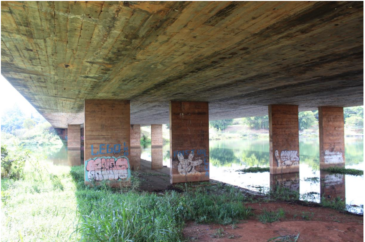
FIGURA 18 – Pilares em contato com o Lago Paranoá
