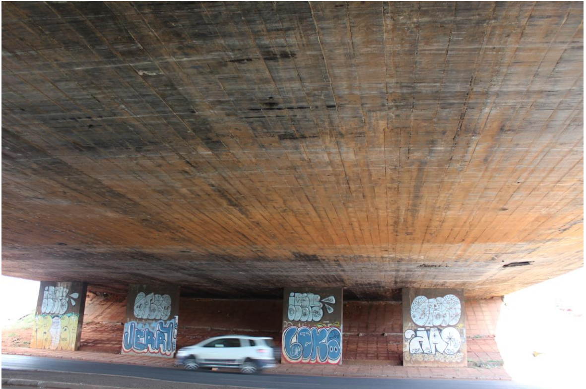
FIGURA 19 – Pilares da Ponte do Bragueto
