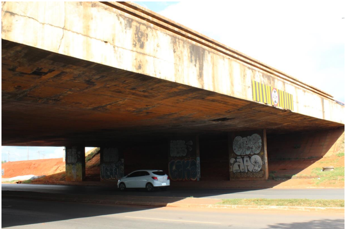
FIGURA 17 – Fachada Sul da Ponte do Bragueto
