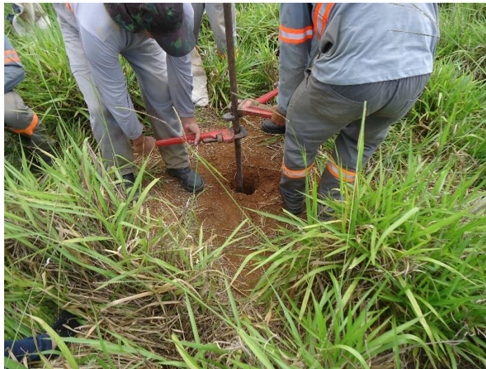
Figura 8 - Sondagem a Trado
