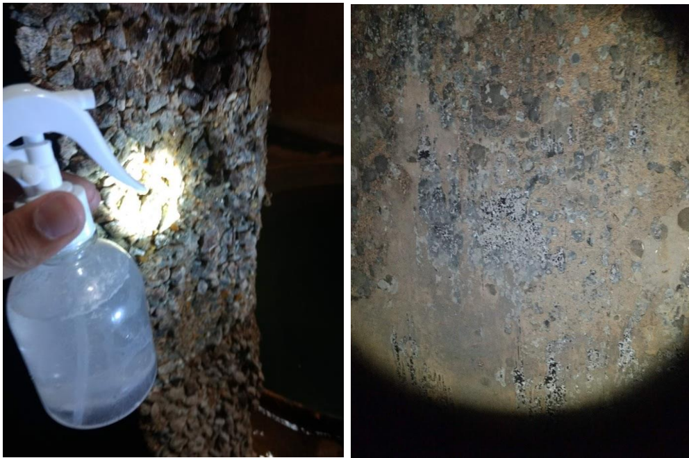
Figura 28 - Teste de Carbonatação
