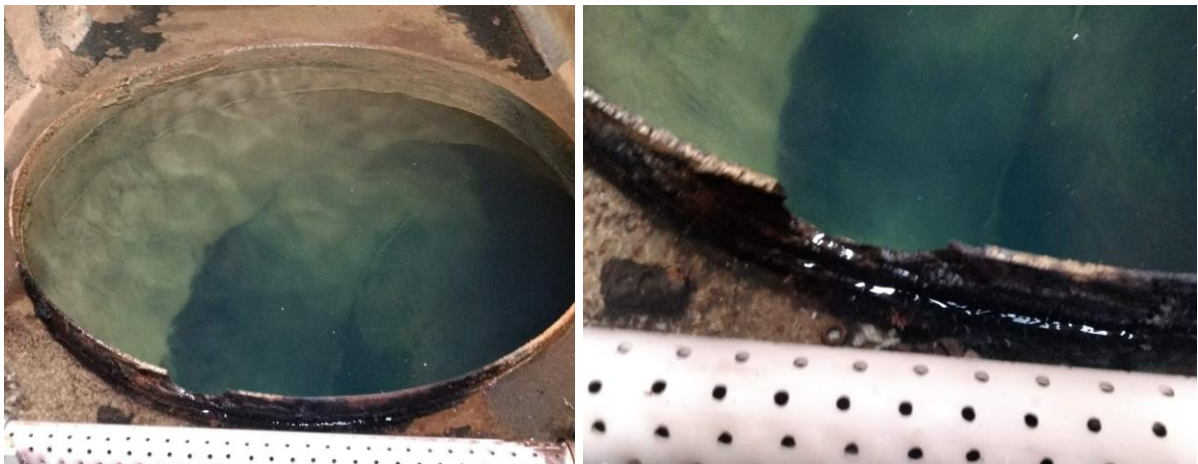
Figura 14 - Corrosão na borda da adutora
