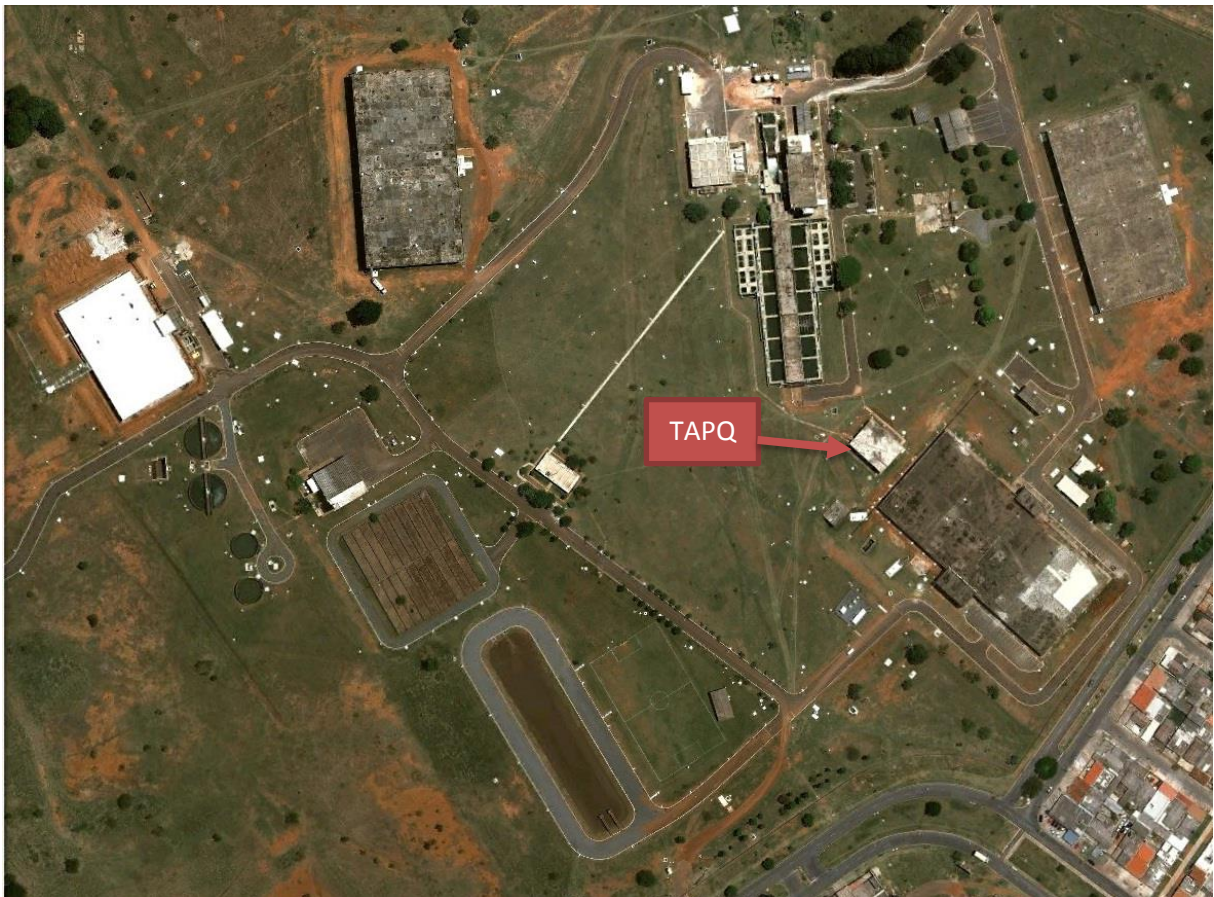
Figura 7 - Vista panorâmica da Estação de Tratamento de Água Rio Descoberto
