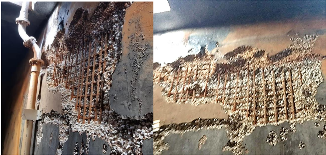
Figura 15 - Desagregação do concreto
