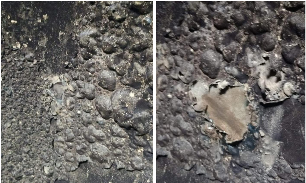
Figura 20 - Impermeabilização com bolhas
