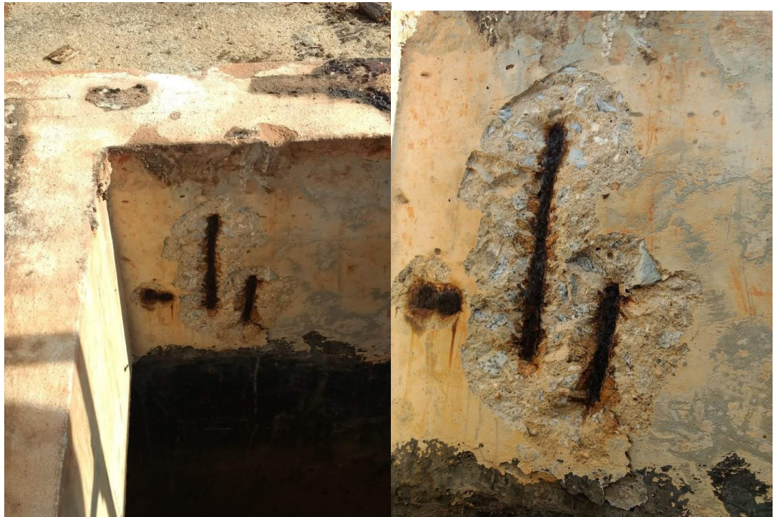
Figura 12 - Corrosão de Armadura
