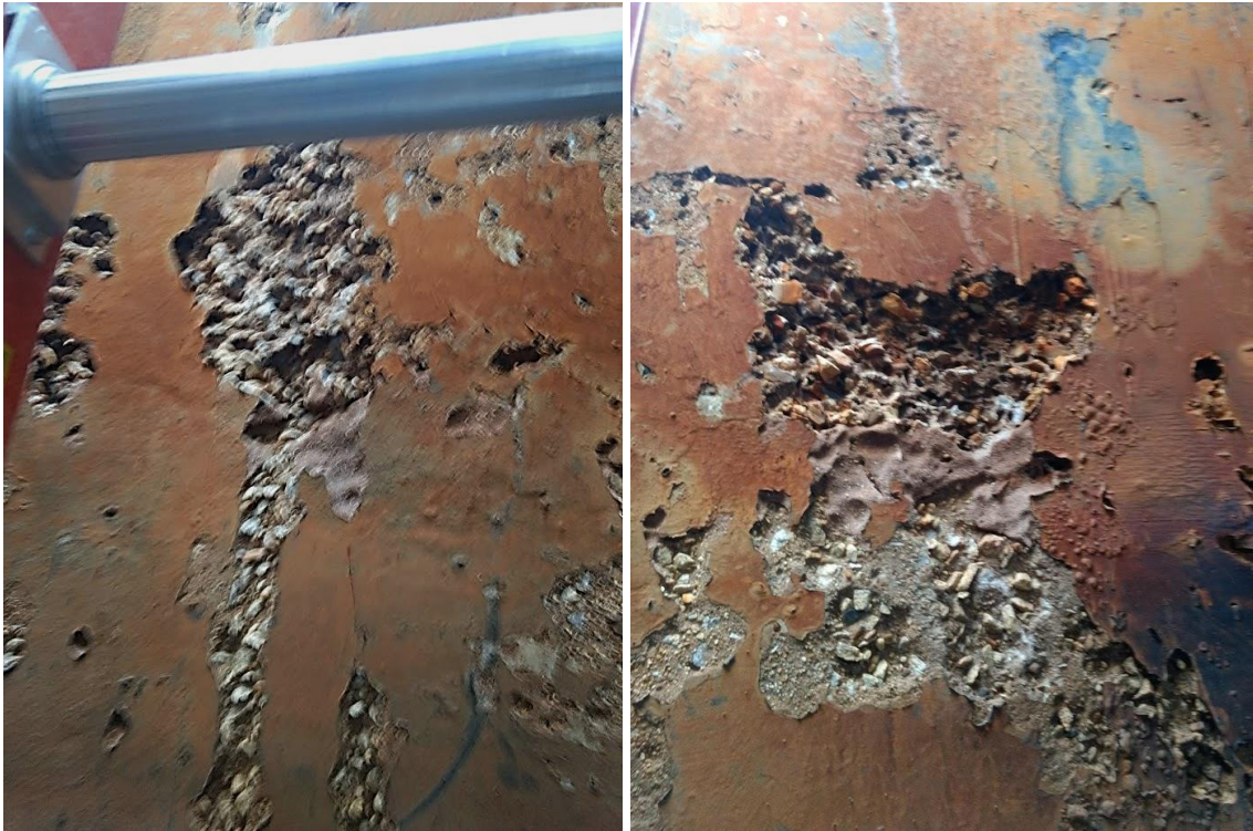
Figura 13 - Desagregação do concreto
