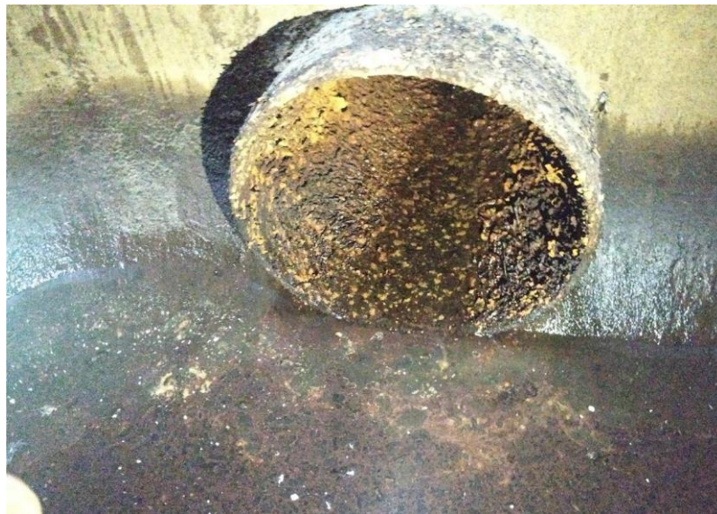
Figura 27 - Corrosão no tanque de descarga
