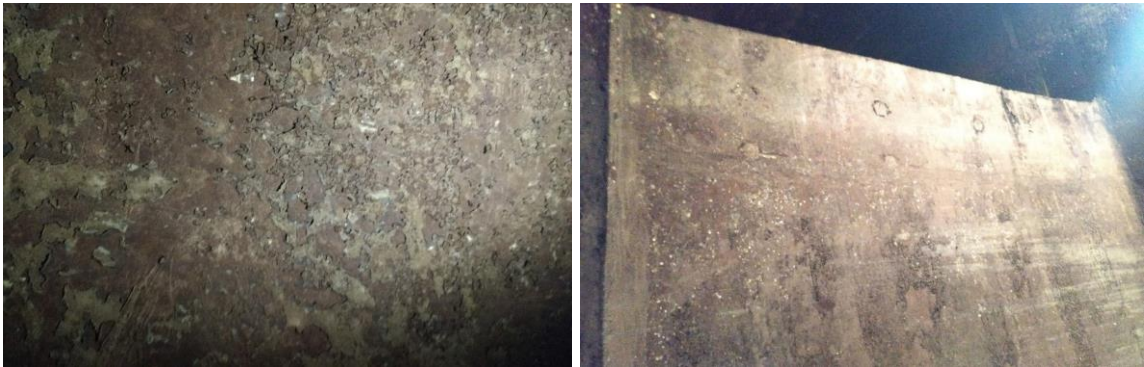
Figura 24 – Locais onde não existe mais a impermeabilização
