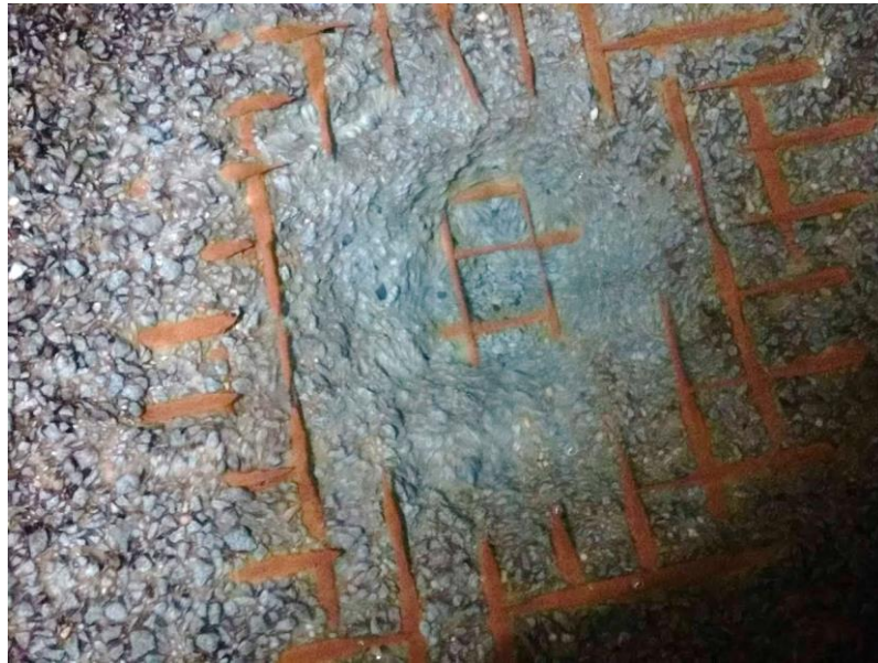
Figura 23 - Buraco com perda de seção na ferragem da segunda camada.
