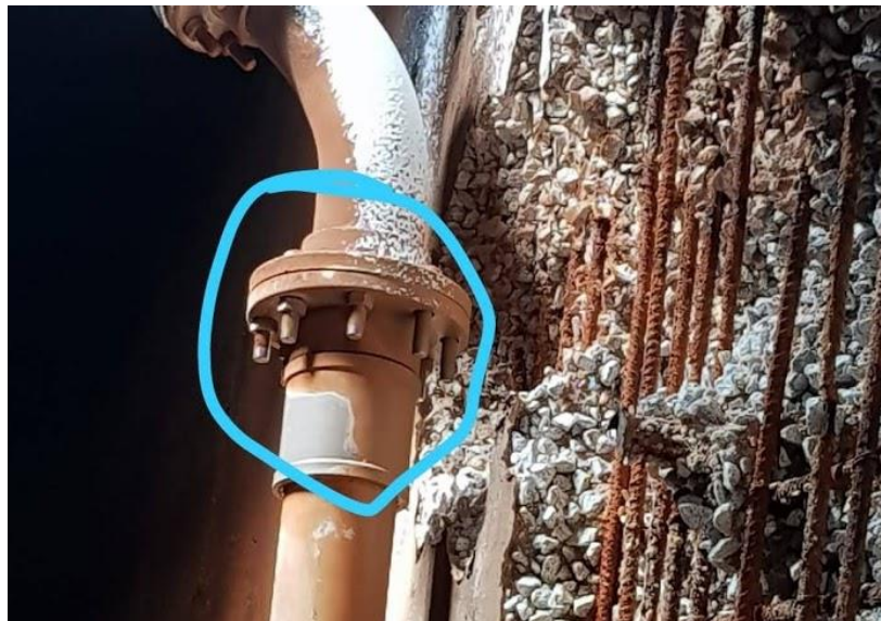
Figura 16 - Parafuso da Tubulação sem porca
