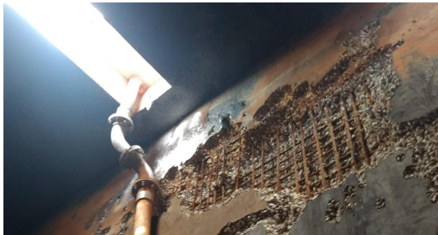
Figura 17 - Manchas brancas, próximo ao duto de cloro.
