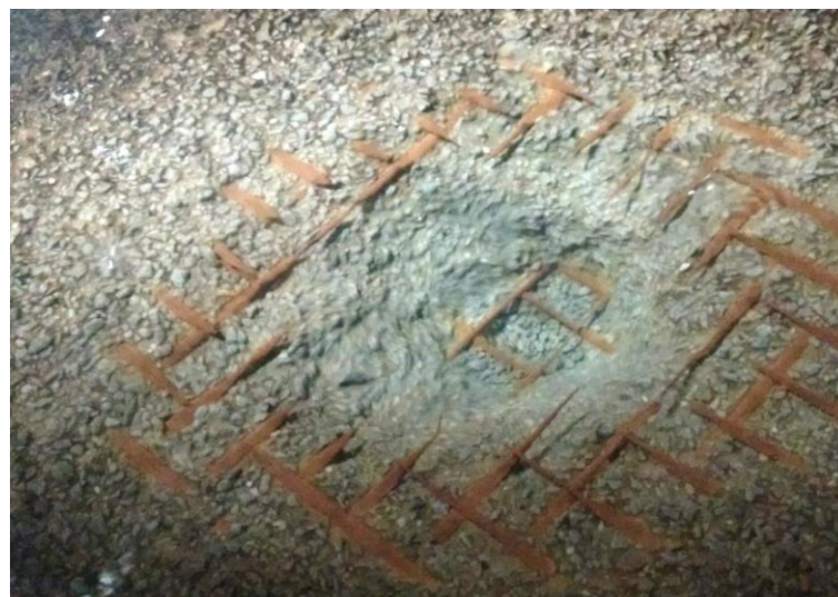
Figura 22 - Buraco com perda total da ferragem na primeira camada.
