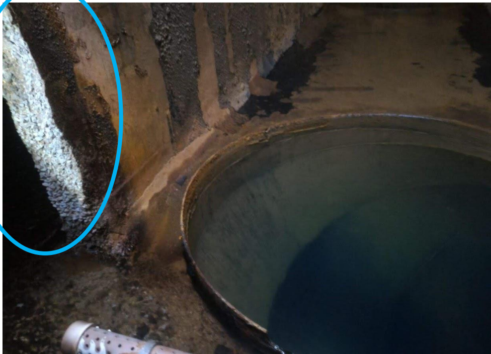
Figura 18 - Desagregação do concreto no canto da parede
