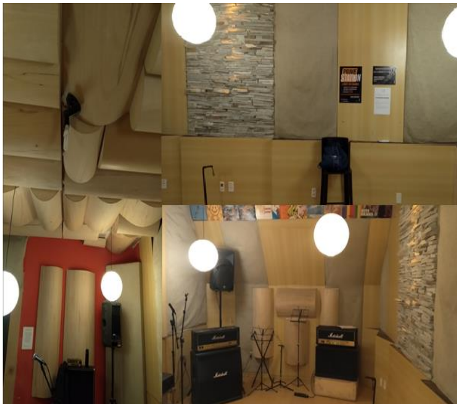
Figura 9 – Detalhes do teto e paredes com difusores.
