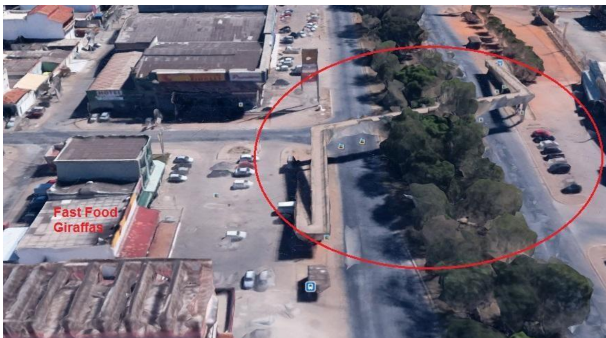
Figura 8 - Localização da passarela 2.
