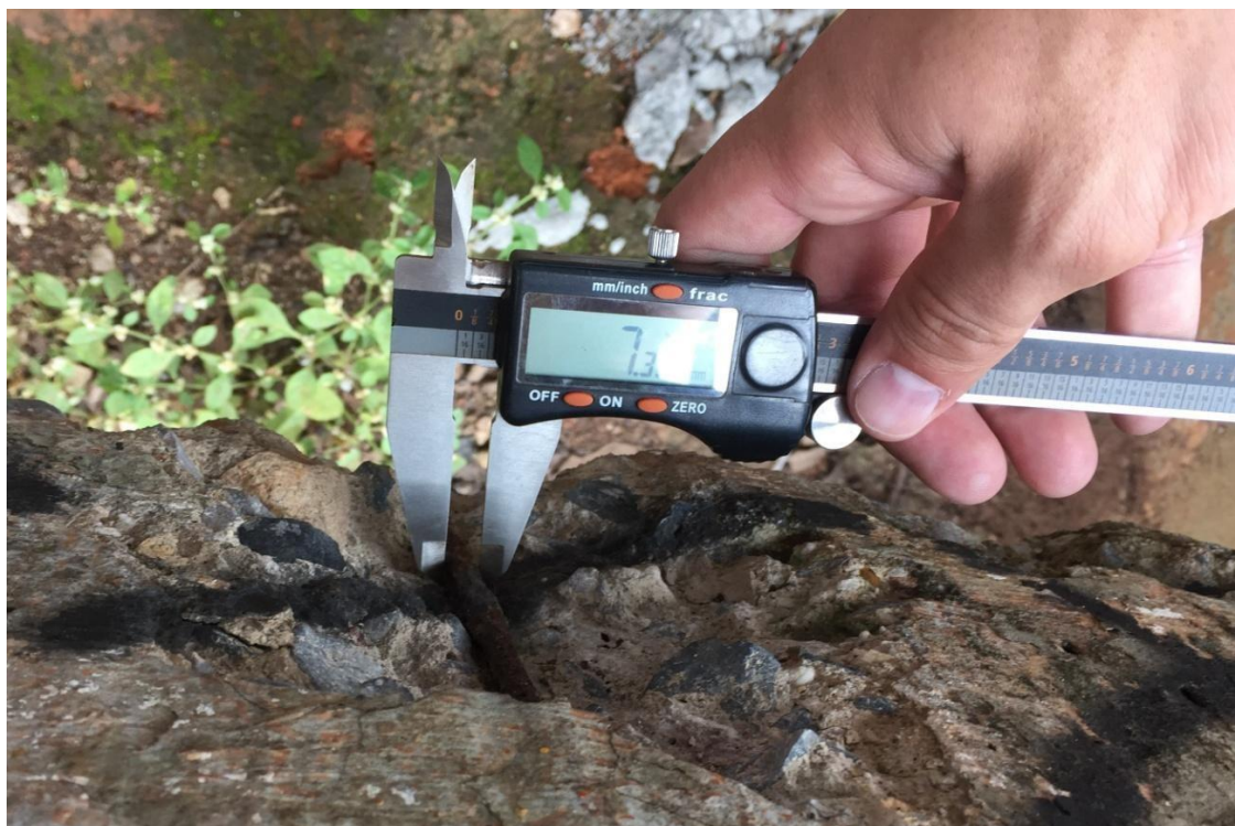
Figura 17 - Aferição da seção da armadura com paquímetro.
