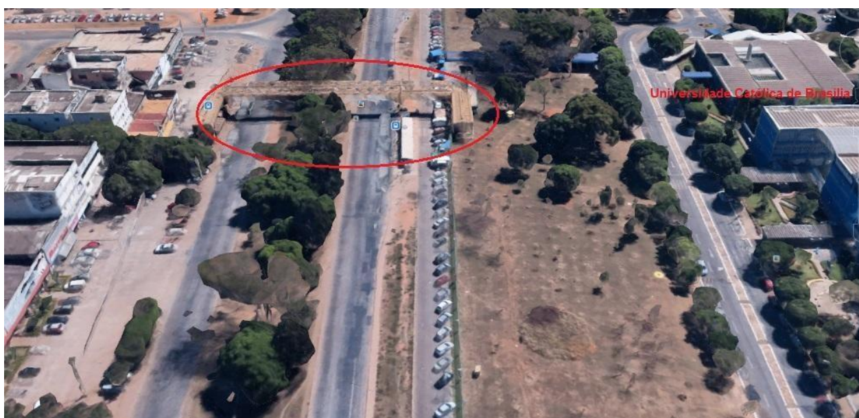
Figura 6 - Localização da passarela 1.
