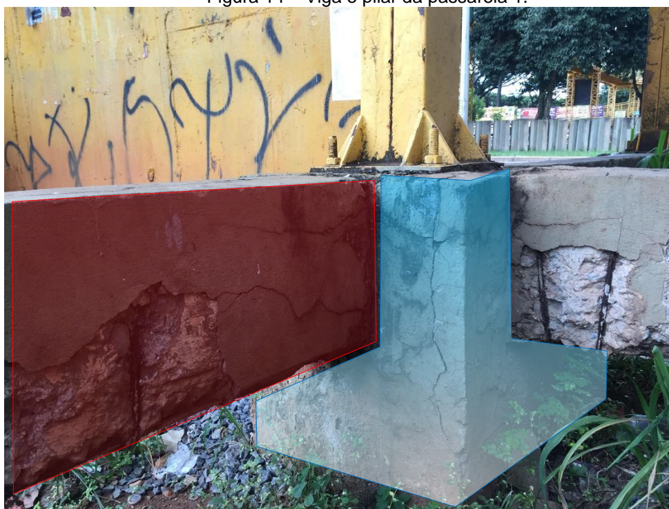
Figura 14 – Viga e pilar da passarela 1.
