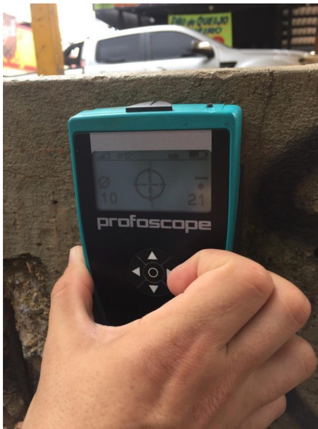
Figura 15 - Aferição de armadura e cobertura com pacômetro.
