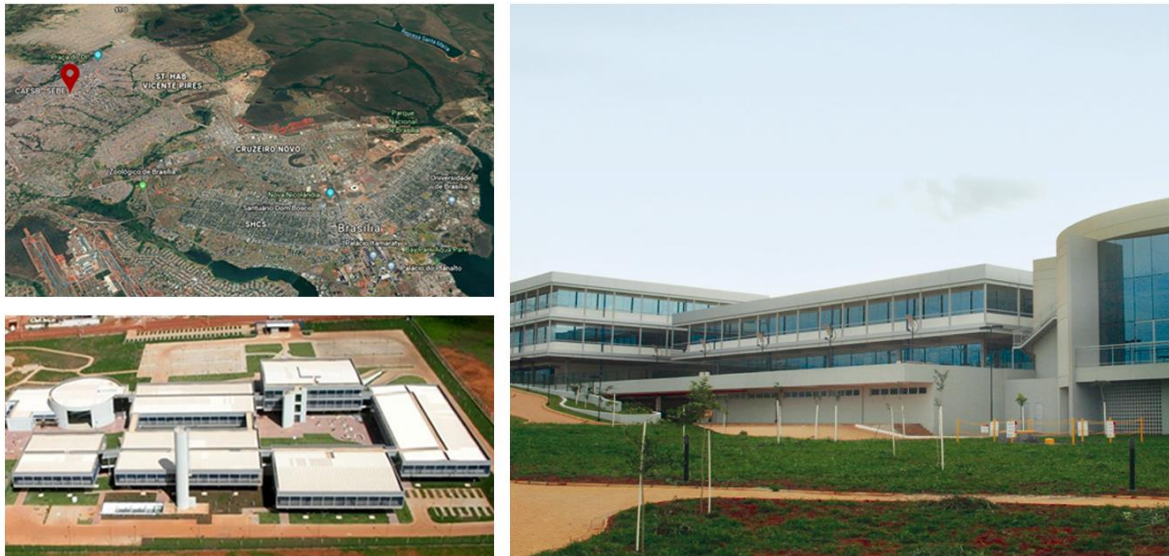
Figura 10 – Localização do edifício Sede Administrativo da Caesb.
