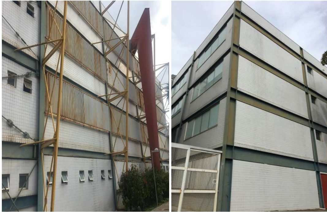
Figura 3-6 Fachadas posterior e lateral do edifício Bloco 9 (Autora, 2018)
