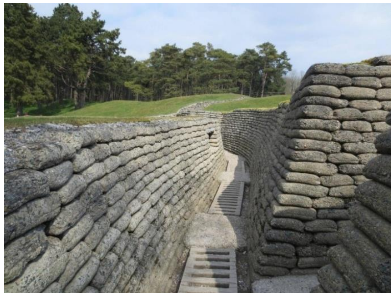
Figura 6 - Muro de saco de solo-cimento
