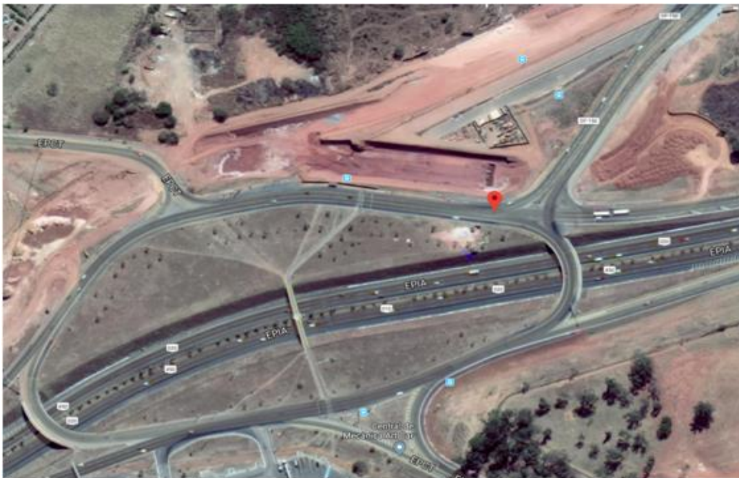
Figura 17 - Vista do talude localizado proximo ao balão do Colorado - DF-150
