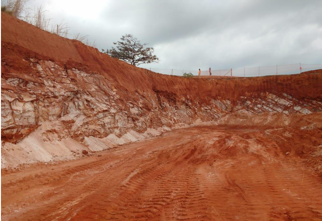
Figura 19 - Vista lateral direita do talude em estudo
