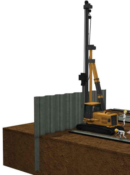
Figura 4 - Execução de Estacas Prancha
