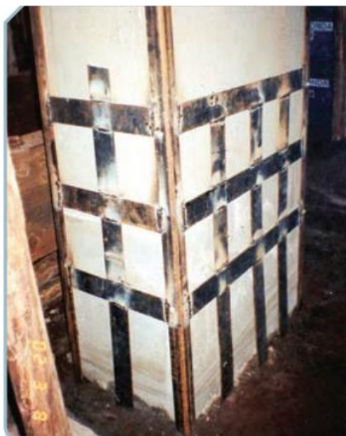
Figura 61 - Início da Segunda Etapa do Reforço do Pilar 19
