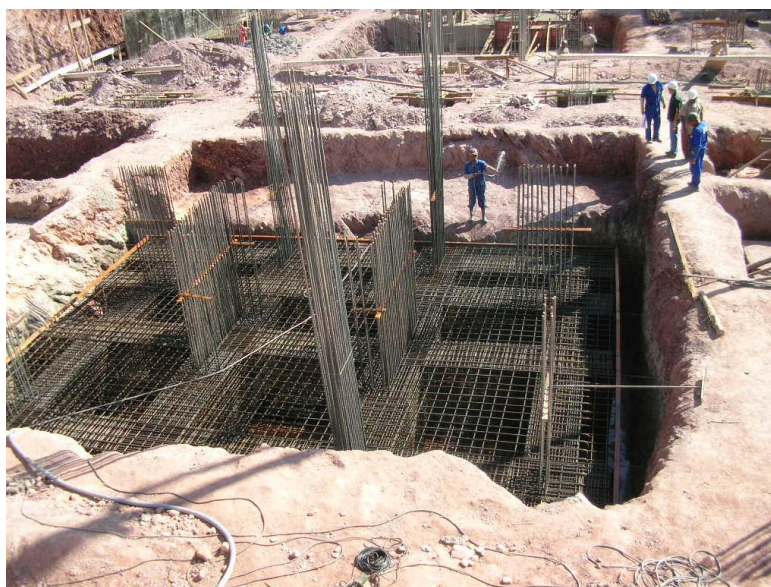
Figura 33 - Preparação de Bloco de Fundação de 450m 3
