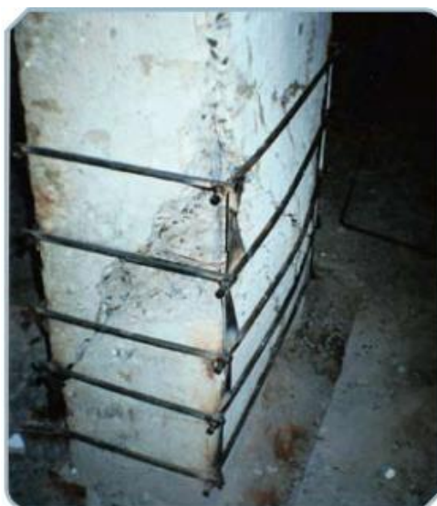
Figura 54 - Recuperação Imediata do Pilar 19.
