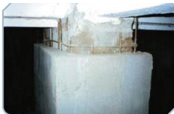
Figura 60 - Primeira Etapa do Reforço do Pilar 19
