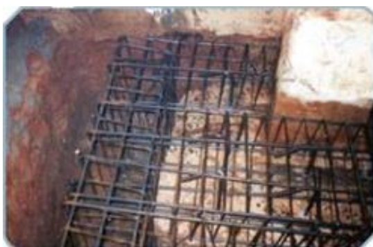
Figura 59 - Reforço do Bloco de Coroamento
