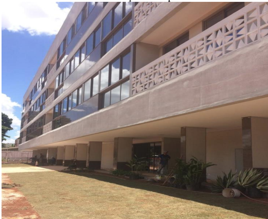
FIGURA 5 - Construção do empreendimento em estudo
