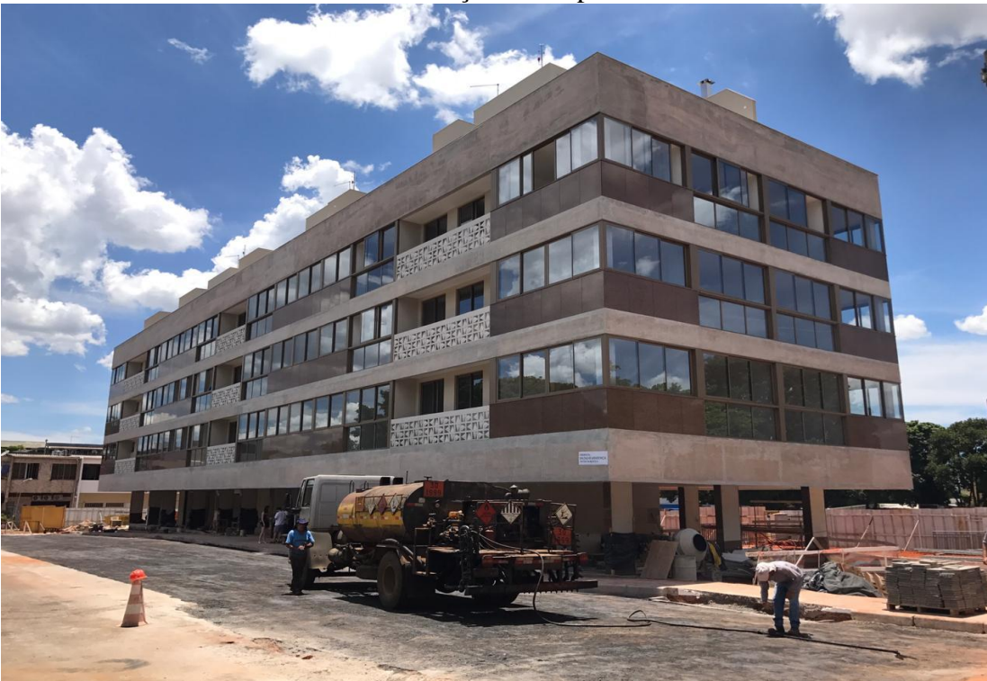
FIGURA 4 – Construção do empreendimento em estudo
