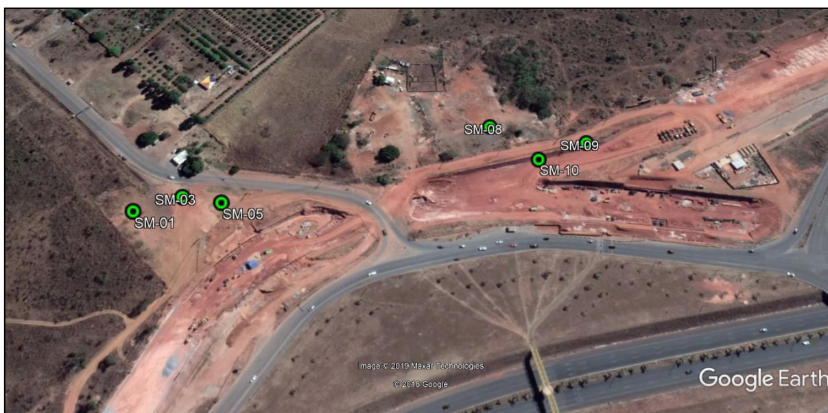
Figura 22 - Locação dos furos de sondagem.
