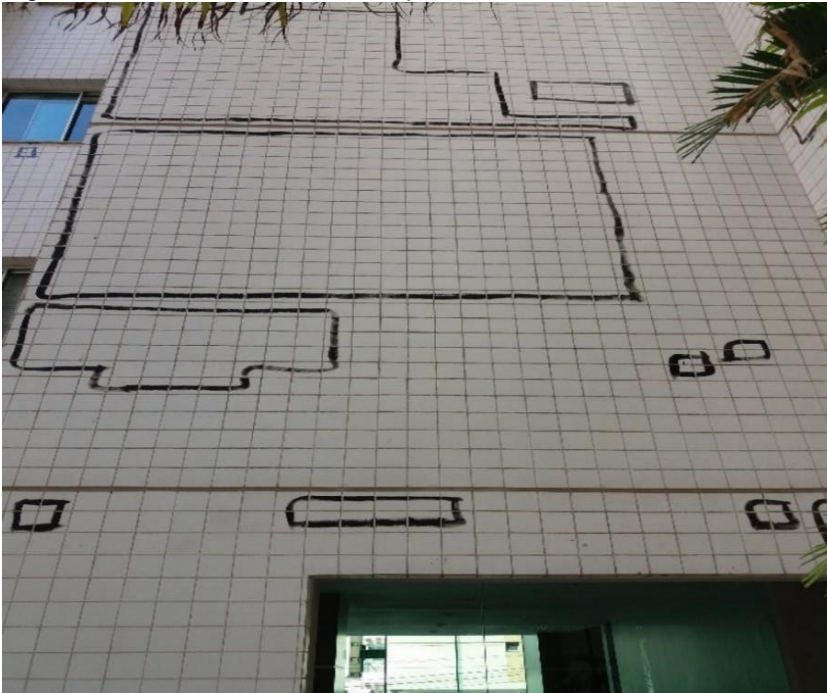
Figura 19 - Resultado do teste de percussão na fachada.
