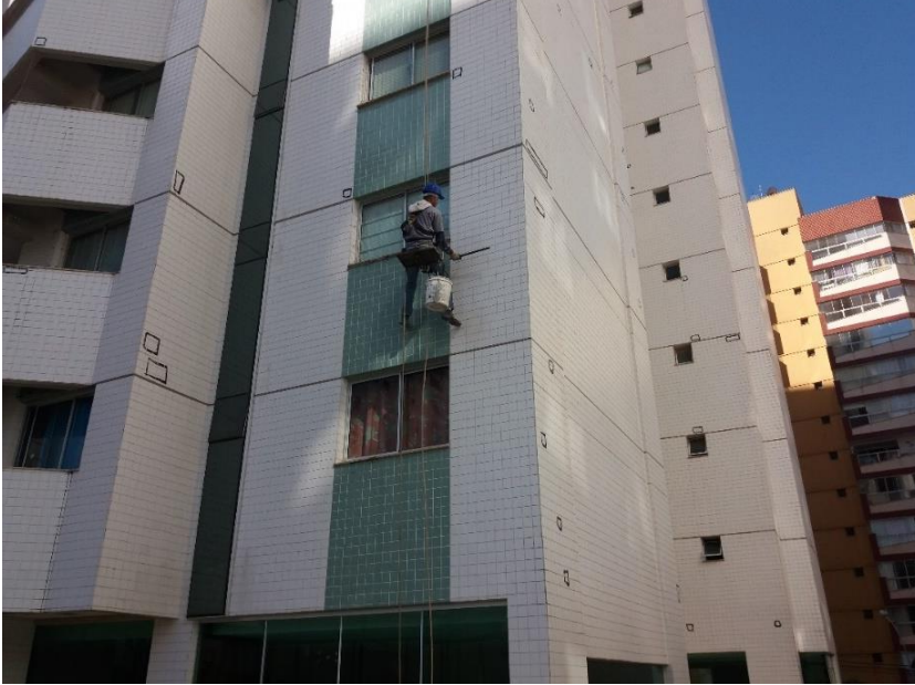
Figura 18 - execução do teste de percussão.
