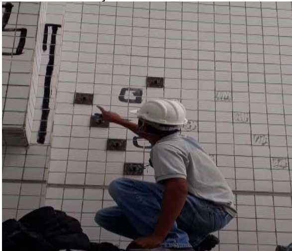
Figura 20 – Ensaio de resistência de aderência à tração – Bloco A Fachada 1.
