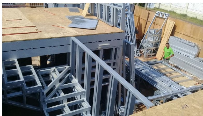
Figura 10 – Montagem de painéis no canteiro
