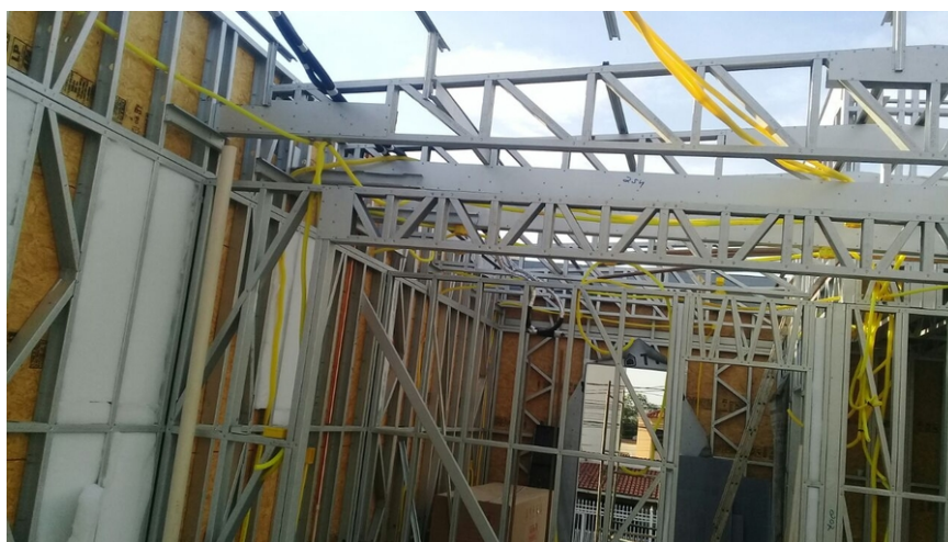
Figura 14 – Treliça de cobertura confeccionada com perfis galvanizados formados a frio
