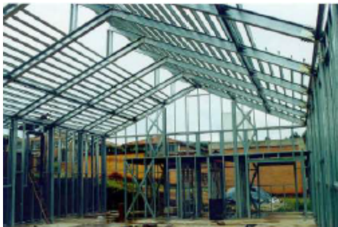
Figura 24 – Telhado estruturado com caibros
