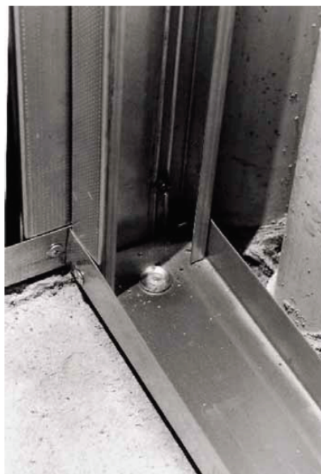
Figura 8 – Fixação do painel na fundação
