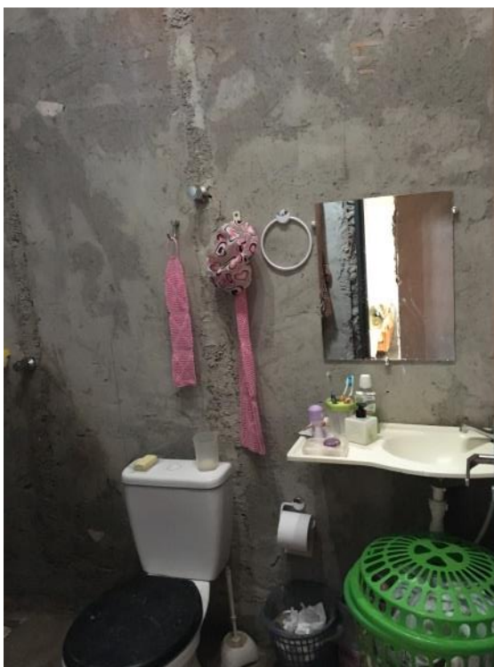
Figura 61 - Banheiro da casa do Soliron após a Assistência Técnica
