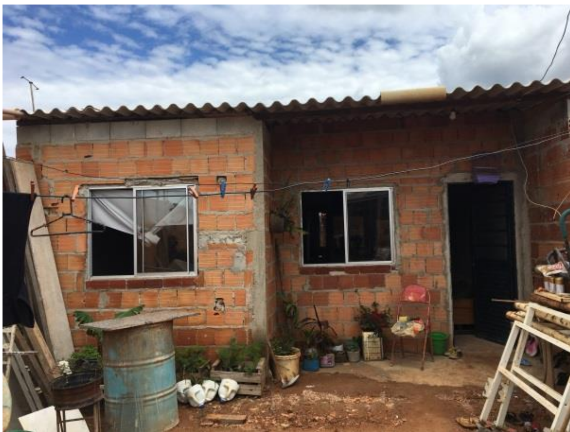
Figura 56 - Fachada da casa do Soliron após a Assistência Técnica
