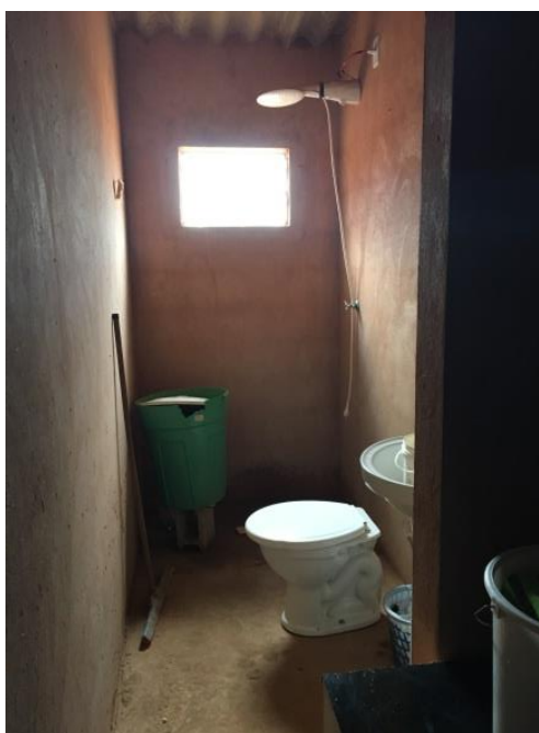
Figura 82 – Vista 3: Banheiro da suíte na casa da Amélia
