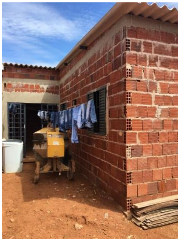
Figura 109 – Nova fachada da casa do Valderi após a Assistência Técnica
