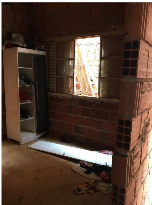
Figura 158 – Vista 6: Novo Quarto após a Assistência Técnica
