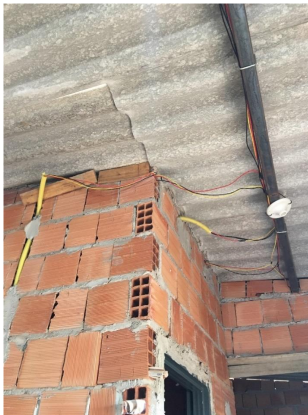
Figura 49 – Novas instalações na casa da Rosely após a Assistência Técnica
