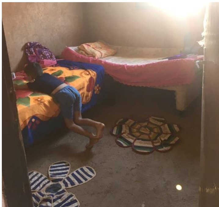
Figura 97 - Quarto Novo da casa do Dalvino após Assistência Técnica
