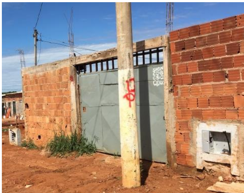
Figura 28 – Alvenaria convencional na Quadra 209 Trecho 2 do Sol Nascente
