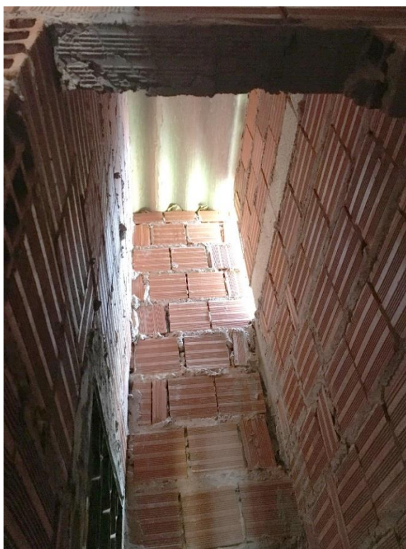
Figura 120 – Vista 2: Poço de Ventilação/Illuminação da casa do Daltro
