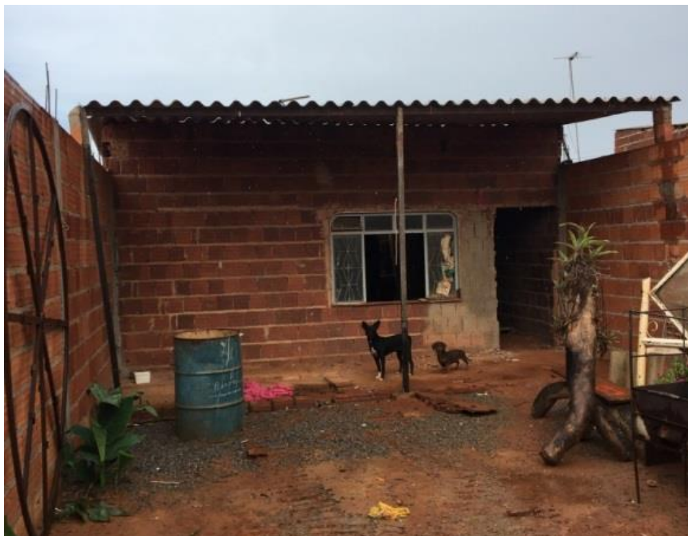
Figura 53 – Fachada da casa do Soliron
