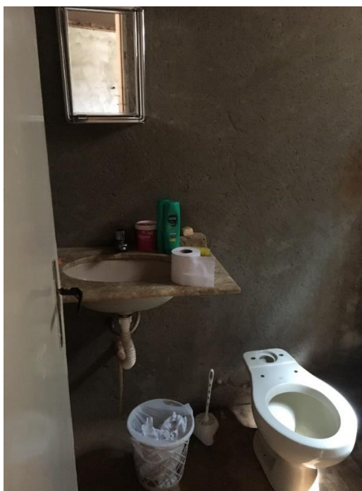
Figura 143 – Vista 5: Banheiro da casa da Marly após Assistência Técnica
