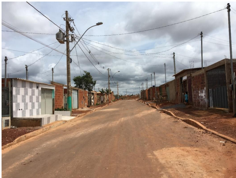
Figura 20 - Quadra 209 – Trecho 2 em novembro de 2018
