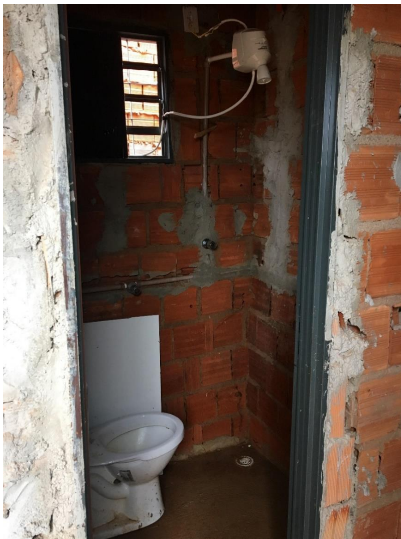
Figura 48 – Vista 6: Banheiro da casa da Rosely após a Assistência Técnica
