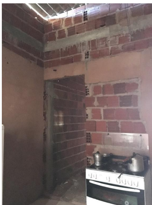
Figura 110 - Cozinha da casa do Valderi após a Assistência Técnica
