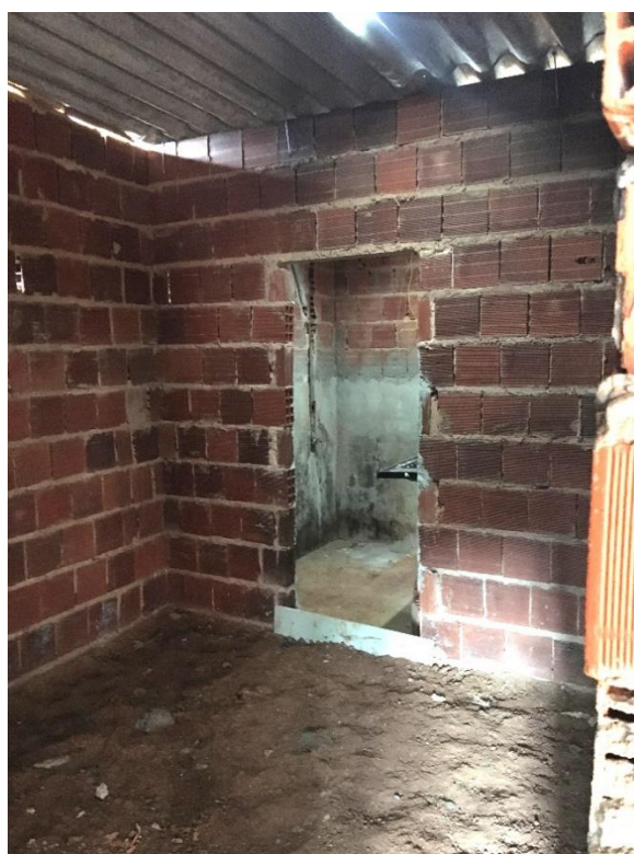
Figura 55 – Vista 2: Suíte da casa do Soliron
