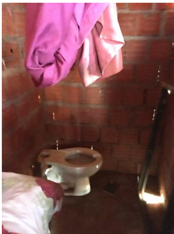
Figura 41 – Vista 1: Banheiro da casa da Rosely
