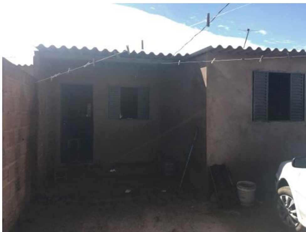
Figura 96 - Fachada da casa do Dalvino após Assistência Técnica
