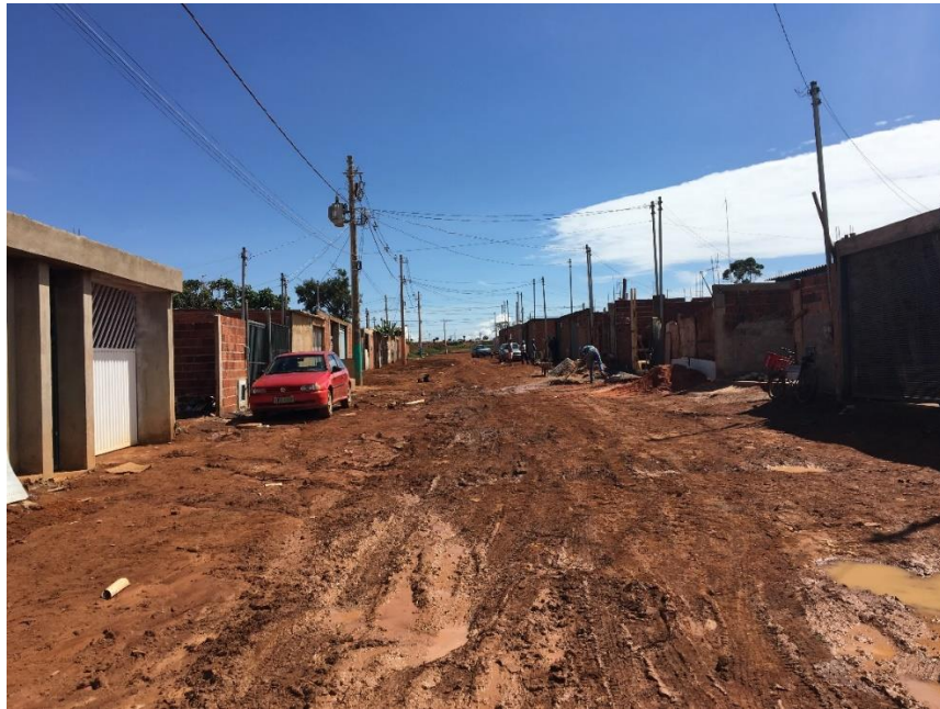
Figura 19 – Quadra 209 – Trecho 2 em abril de 2018
