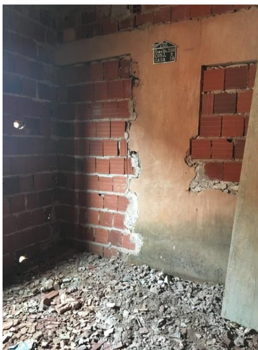
Figura 112 - Novos ambientes na casa do Valderi após Assistência Técnica
