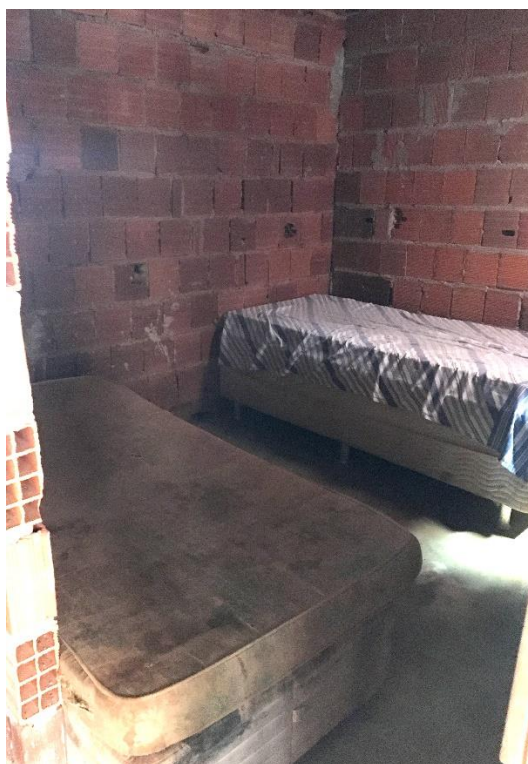
Figura 159 – Vista 7: Novo Quarto 2 após a Assistência Técnica
