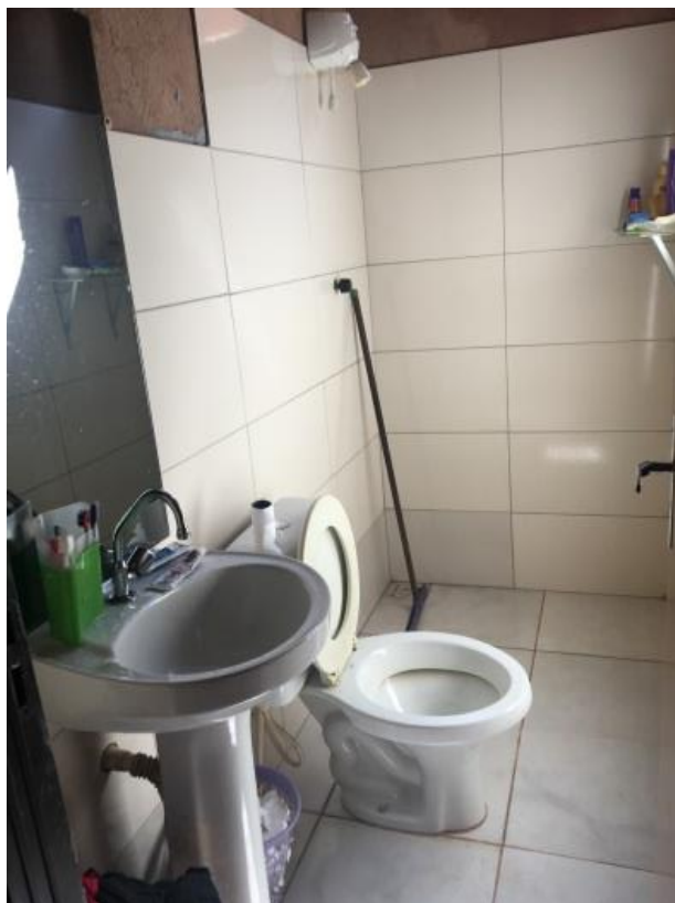
Figura 99 - Banheiro da casa do Dalvino após Assistência Técnica
