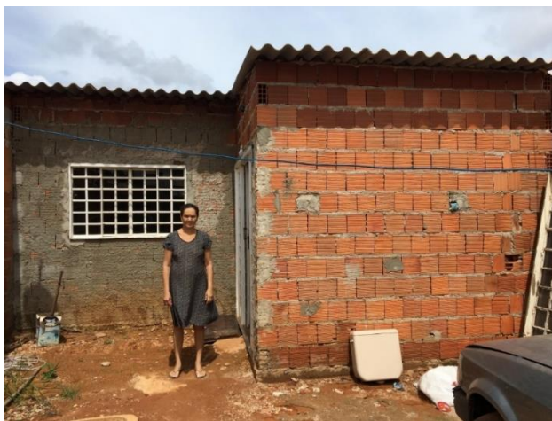
Figura 140 - Fachada da casa da Marly após Assistência Técnica
