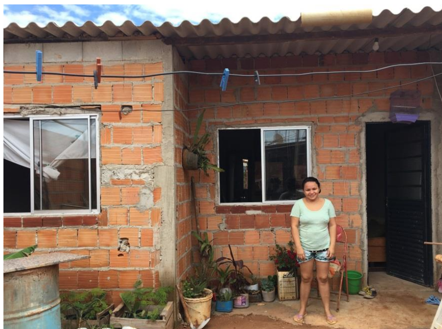
Figura 62 - Moradora da casa do Soliron após a Assistência Técnica
