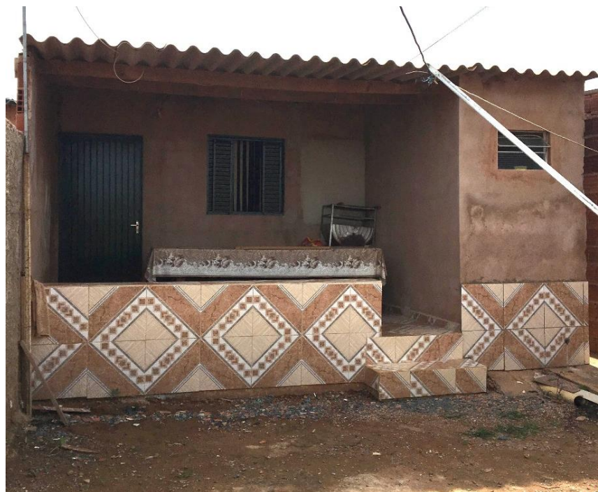
Figura 84 - Fachada da casa da Amélia após a Assistência Técnica
