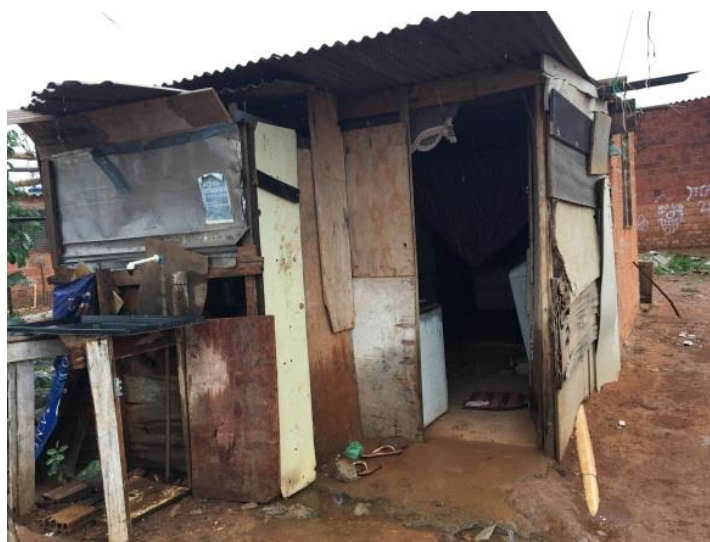
Figura 40 - Fachada da casa da Rosely
