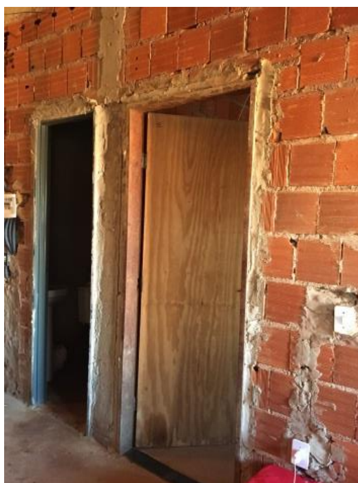
Figura 132 – Vista 10: Novas portas na casa do Daltro após a Assistência Técnica
