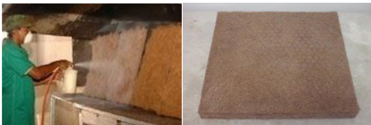
Figura 23: Aplicação de agente antichamas (a) painel concluído (b)
