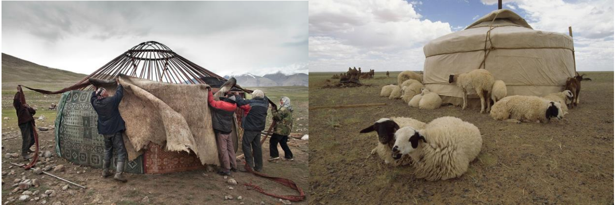
Figura 8: (a) Montagem de Yurt (b) vista externa
