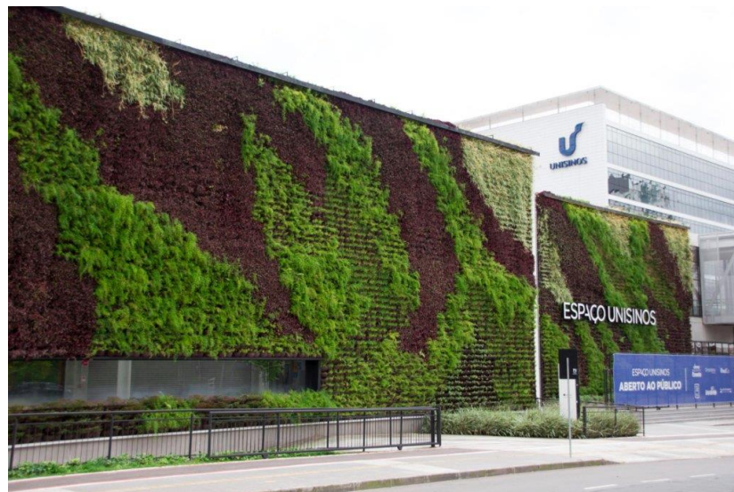
Figura 47: Fachada com aplicação de cobertura vegetal
