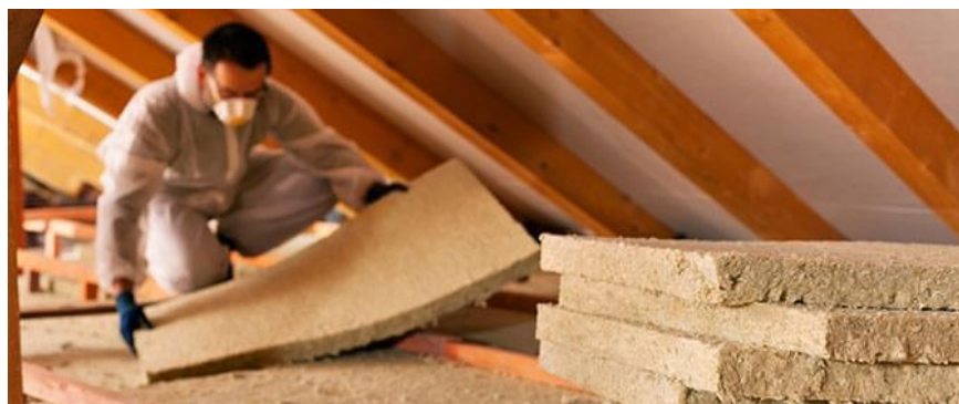
Figura 9: Aplicação de lã de rocha
