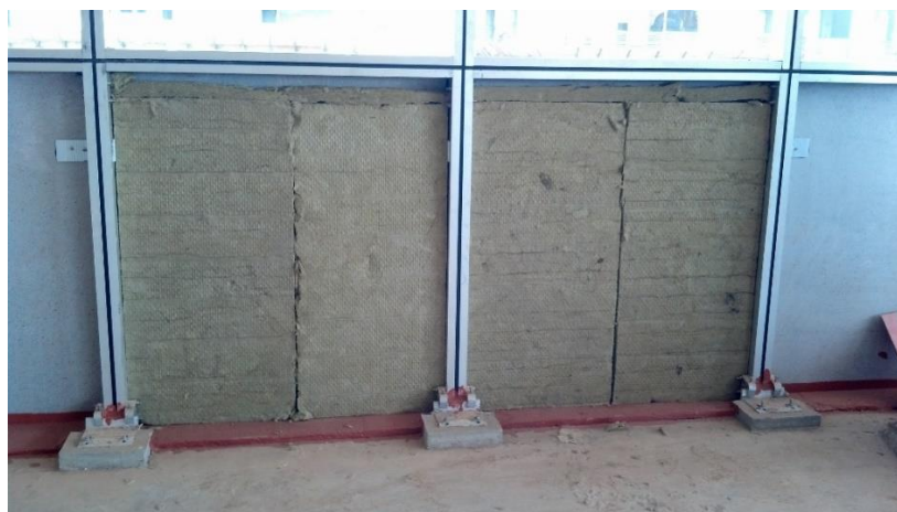
Figura 73: Instalação de lâ de rocha em fachada unitizada
