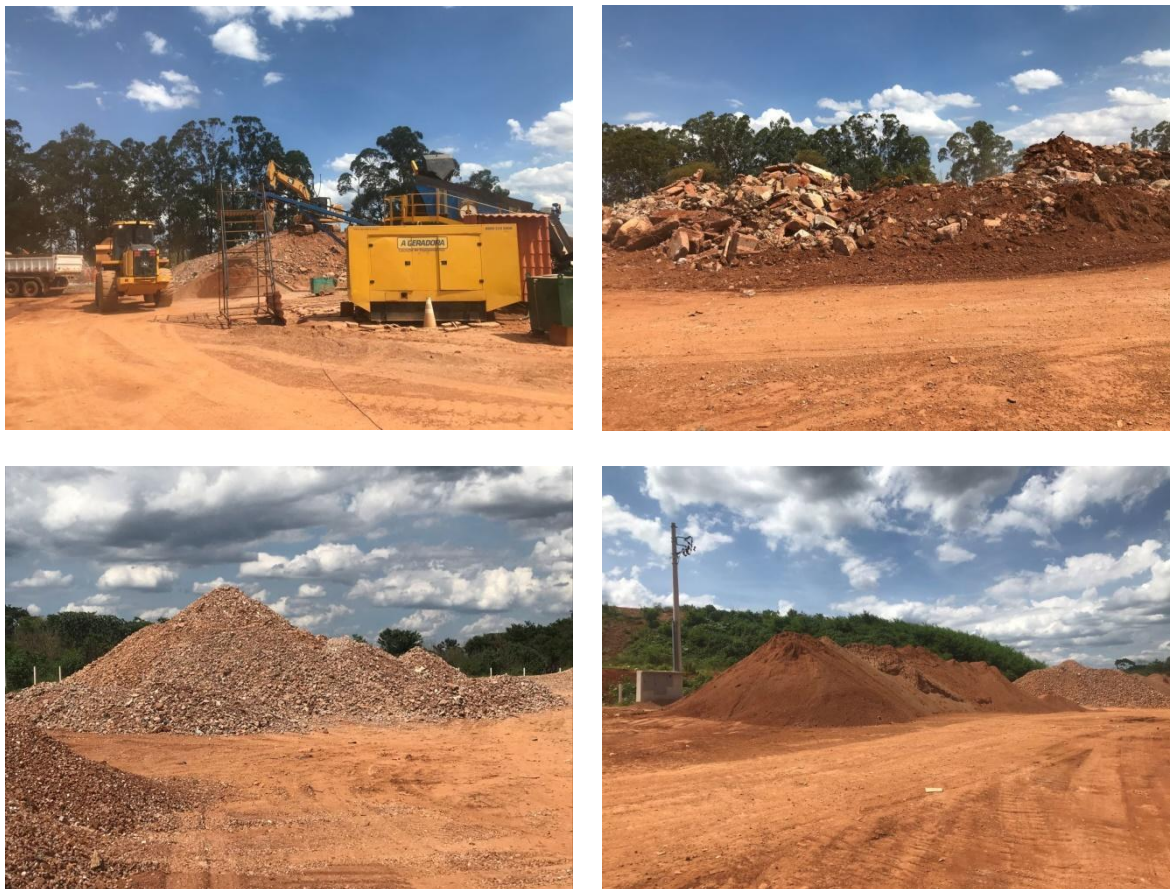
Figura 44 - Britagem de RCC na URE DF
