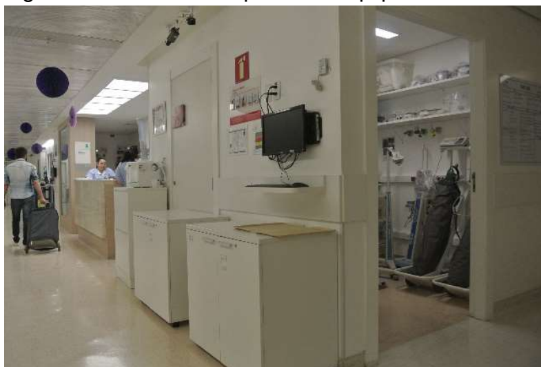
Figura 34: Acesso ao depósito de equipamentos.
