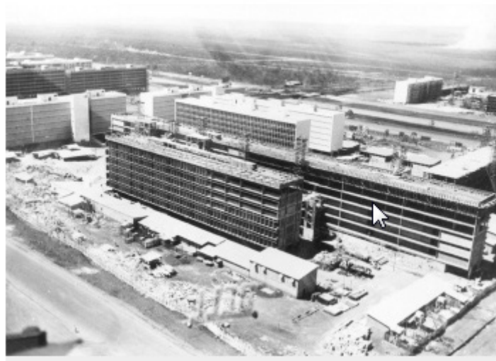
Figura 14 – Edifícios em obras – Brasília, 1960
