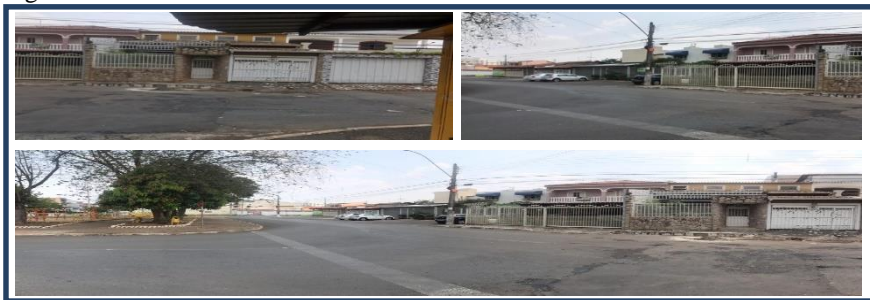
Figura 4 – Panorâmica dos Térreos e Fachadas.
