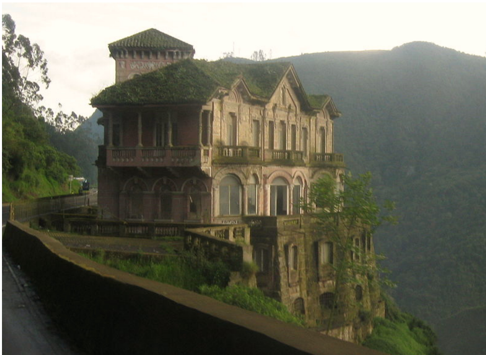
Figura 2. Estado del inmueble posterior al cierre del restaurante Refugio del Salto.
