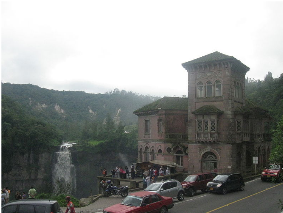
Figura 3. Niveles visibles desde la carretera, fachada norte y occidental.
