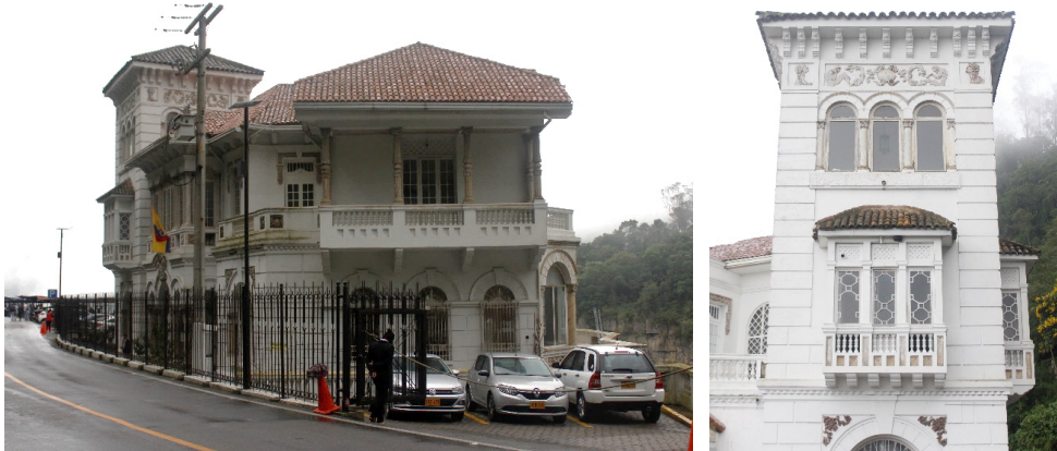
Figuras 9 y 10. Fachada sur vista desde la carretera. Torre costado norte del edificio.
