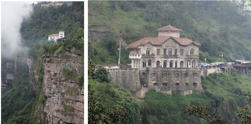
Figuras 4 y 5. Vista de la saliente de roca que soporta el inmueble. Vista del basamento en piedra y los sótanos. Fuente: https://commons.wikimedia.org/wiki/File:Museo_Salto_del_Tequendama.JPG - Petrus.
