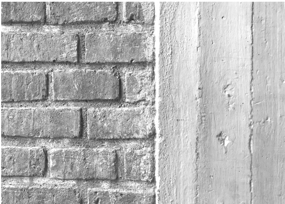
Figura 7. Ladrillo y hormigón en detalle.
