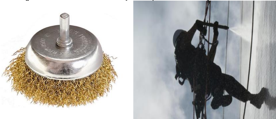
Figura 26 e 27 – Escova de aço e limpeza com hidrojateamento.
