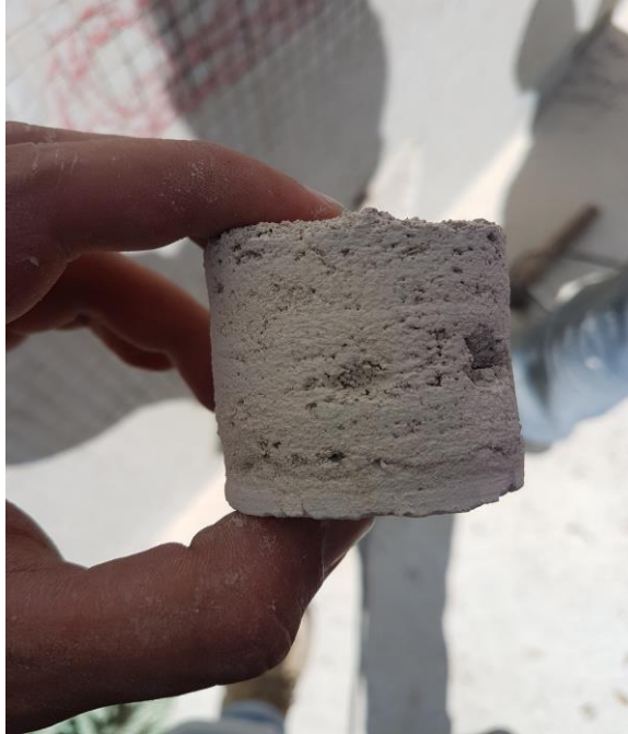
Figura 23 – Espessura do reboco com 4,2cm.
