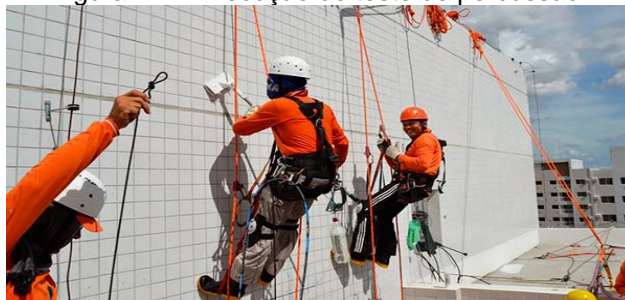
Figura 14 – Execução do teste de percussão.
