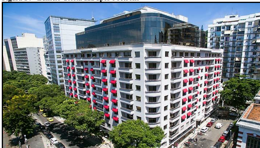
Figura 14 - Edifício Glória 122 após o retrofit
