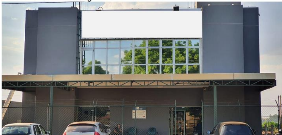
Figura 2 - Fachada frontal da clínica
