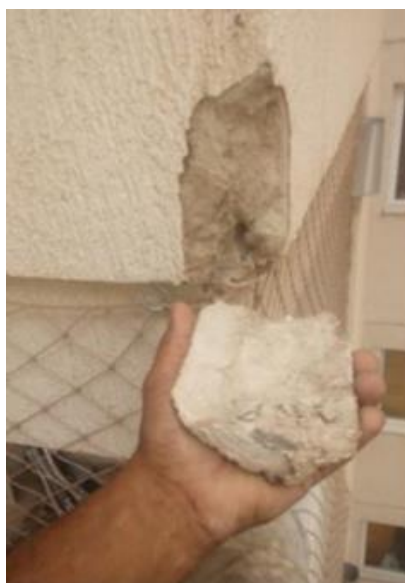
Figura 43 Ensaio de percussão realizado nas fachadas Figura 44 Regiões soltas nas requadrações
