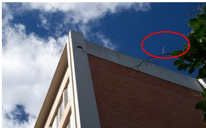
Figura 46_Desplacimento do revestimento na região próxima a platibanda
