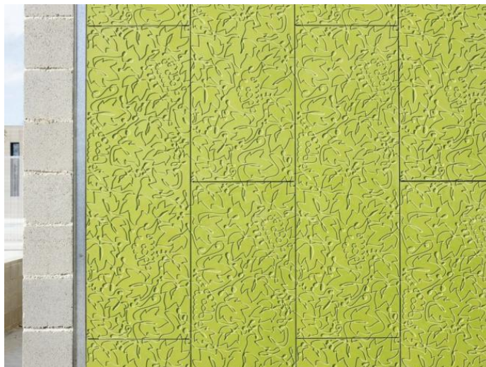
Figura 9 - Detalhe da fachada.
