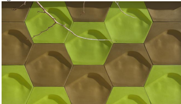
Figura 11 - Detalhe da fachada
