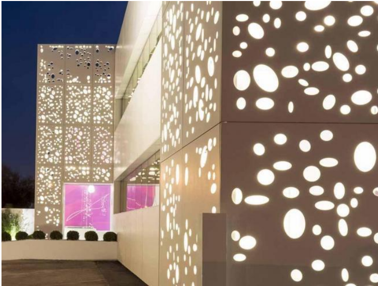
Figura 7 - Detalhe da fachada.
