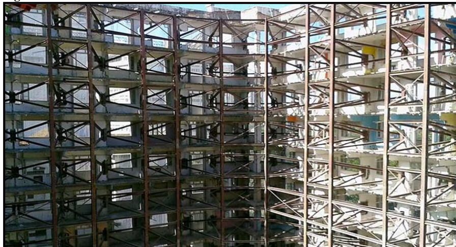
Figura 13 - Foto da estrutura metálica construída atrás das fachadas
