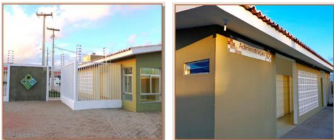
Figura 10 – Guarita e administração do Condomínio Cidade Madura
