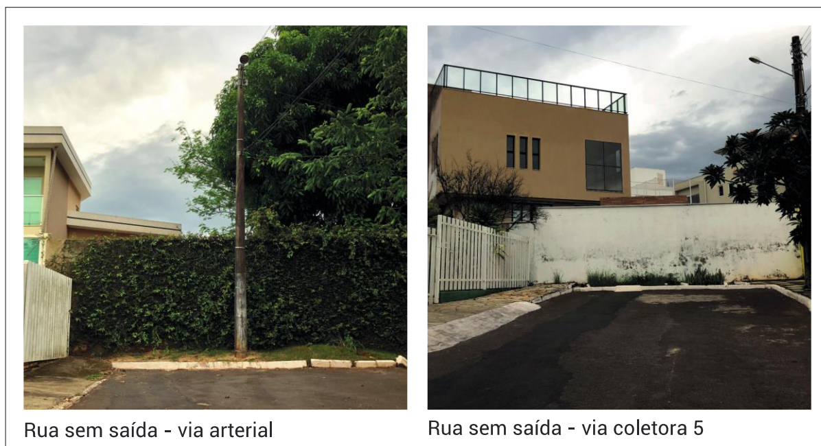
Figura 22: Ruas sem saída no interior do Condomínio.
