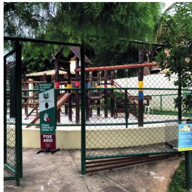
4. Playground em área remanescente não prevista em projeto
