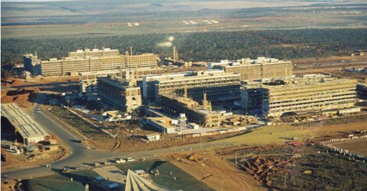
Figura 100: Foto da superquadra 107/108/307/308 Sul durante sua construção, apresentando a topografia existente sem interferências de edificações pré-existentes.
