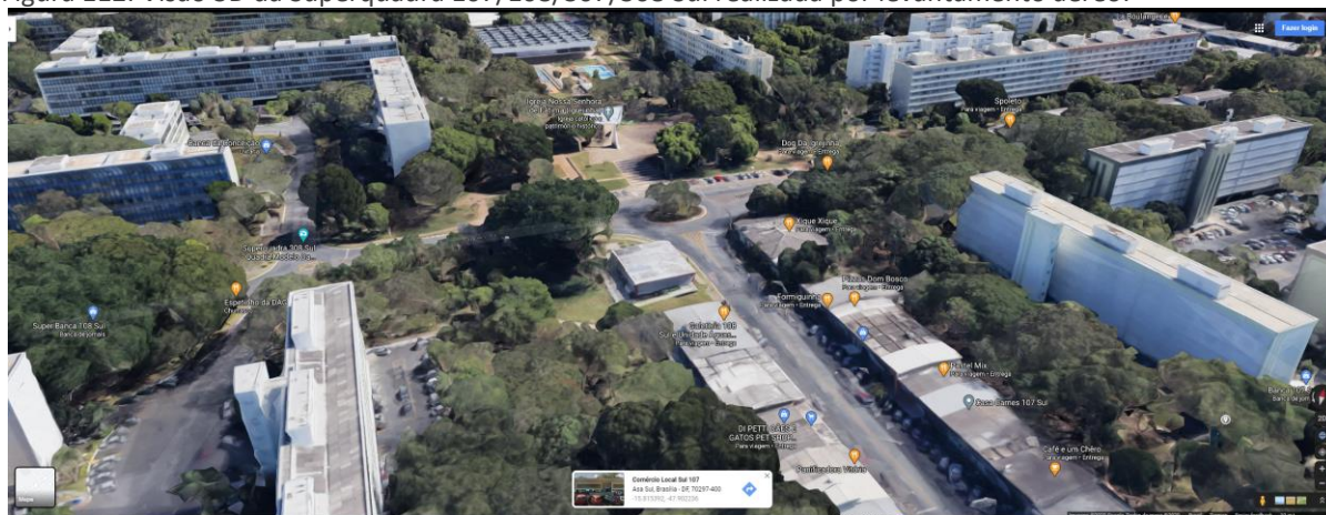
Figura 112: Visão 3D da Superquadra 107/108/307/308 Sul realizada por levantamento aéreo.
