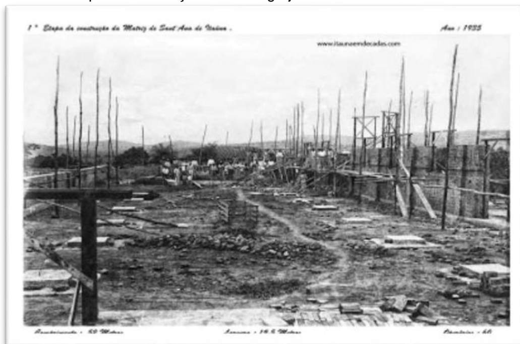
Figura 23 - 1ª etapa da construção da nova Igreja de Nossa Senhora de Santana – 1935
