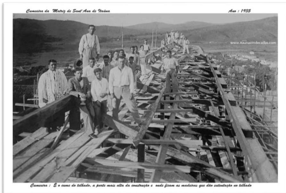
Figura 25 - Instalação do telhado da nova Igreja de Nossa Senhora de Santana – 1935
