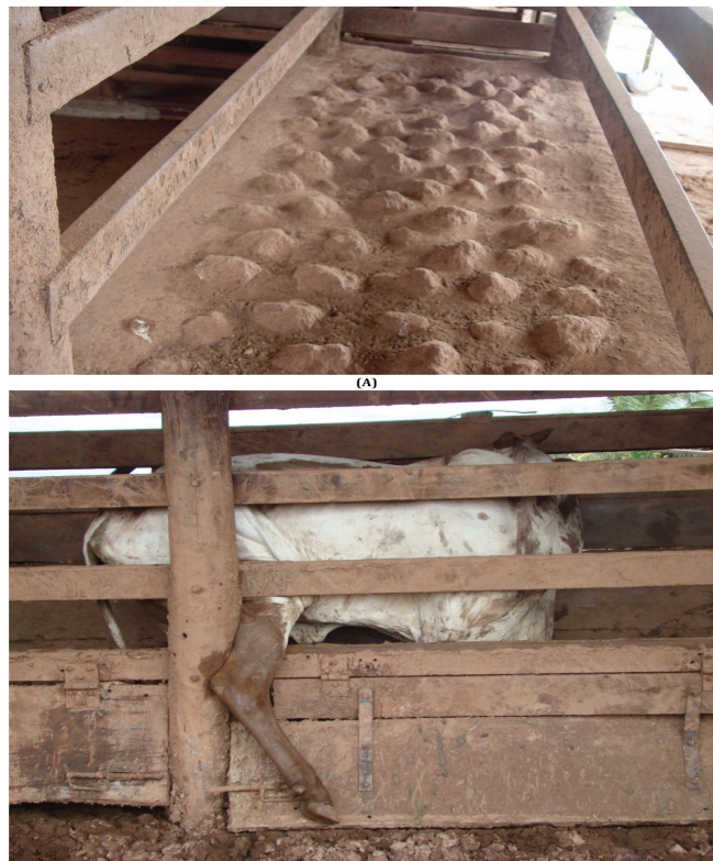
Figura 15- Pisos irregulares e aberturas largas nas laterais das seringas
