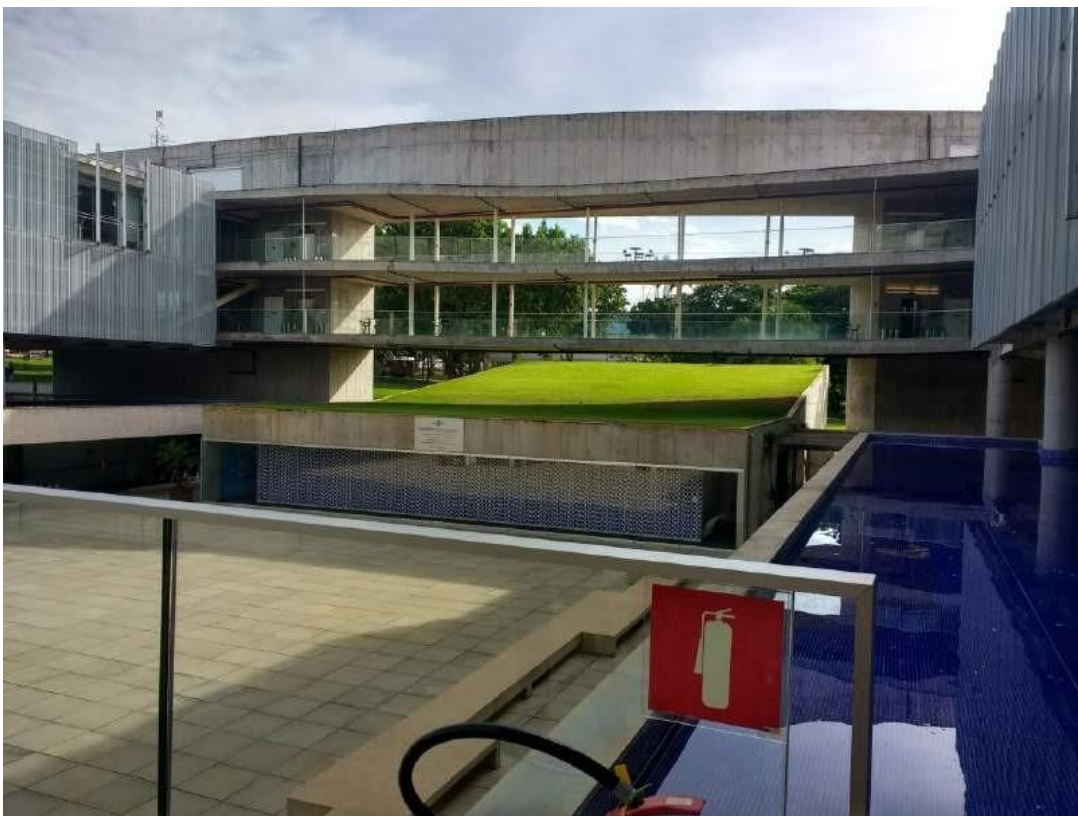
Figura 3: Circulação vazada e espelho d'água.
