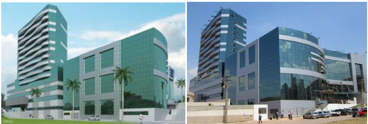
Figura 44 - Modelo BIM do Hospital de Águas Claras à esquerda e construção real à direita.
