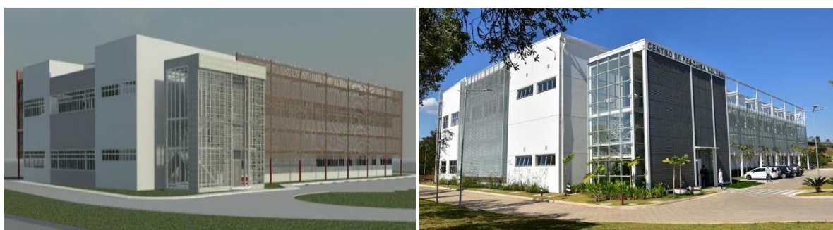
Figura 49 - Modelo BIM do Centro de Pesquisa Boldrini à esquerda e foto da construção real à direita.
