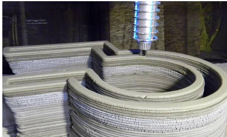
FIGURA 12: IMPRESSÃO UTILIZANDO A METODOLOGIA CONCRETE PRINTING
