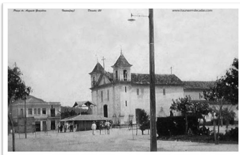
Figura 3 - Antiga Igreja do Rosário – demolida para a construção da nova Igreja de Nossa Senhora do Santana
