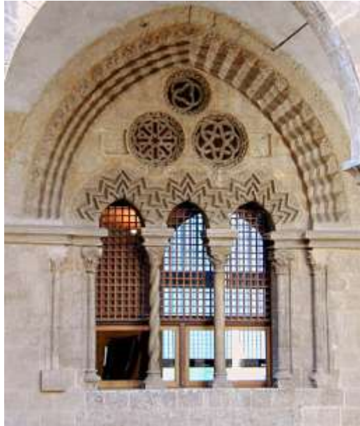
Figura 810: Janelas da fachada detalhadas em pedra lava.
