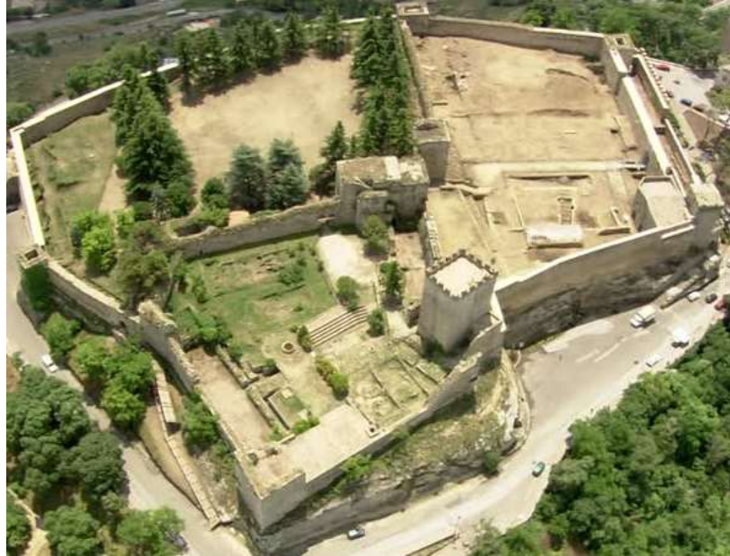
Figura 952: Detalhe Torre Pisana.
