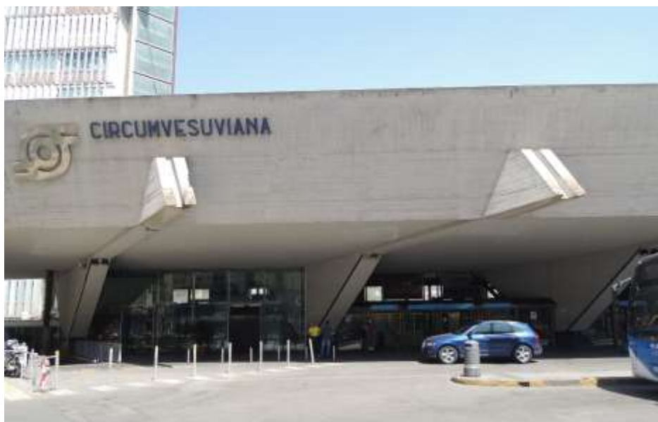
Figuras 92 a 95: Estação de trem Circumvesuviana, Metropolitana local.
