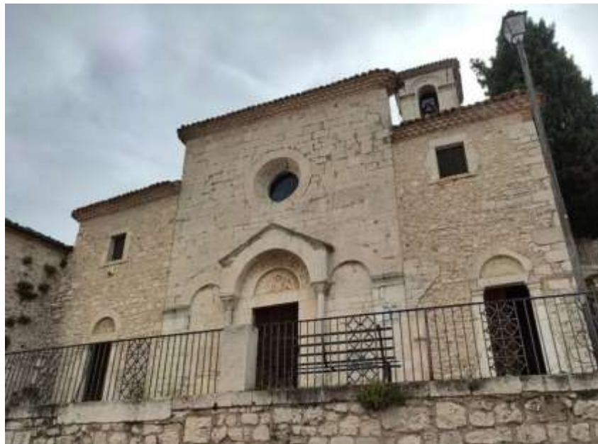
Figura 504: Igreja de São Bartolomeu.
