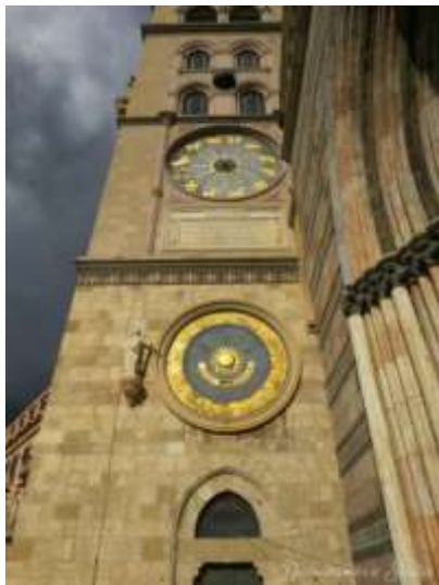
Figura 657: Relógio da catedral, fachada virada para a igreja.
