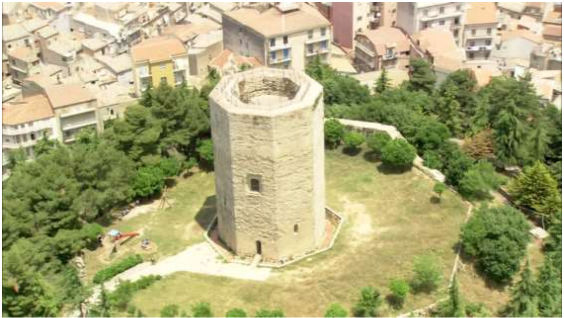
Figura 956: Torre Ennese – Torre di Federico.
